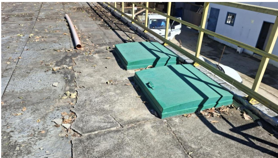
Foto 09 - Tampa de visita
