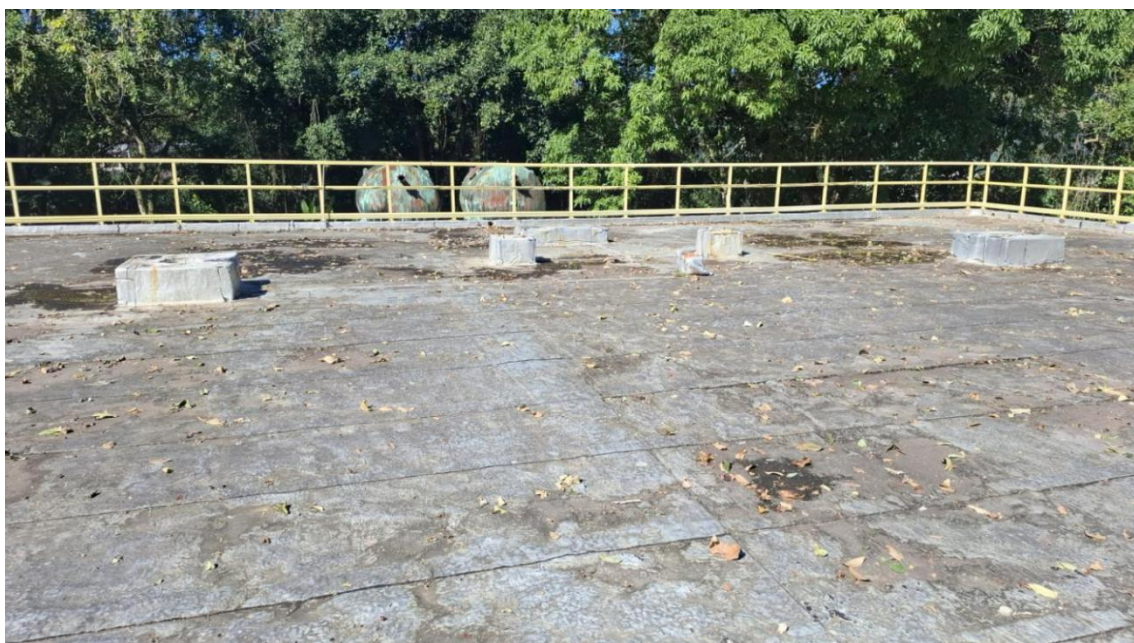
Foto 08 - Superior do reservatório; guarda-corpo instalado
