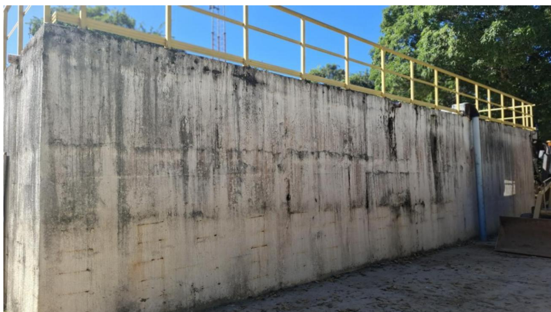
Foto 02 - Estrutura do reservatório
