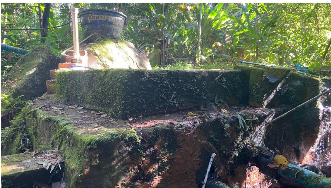
Foto 02 - Estrutura da unidade de tratamento
