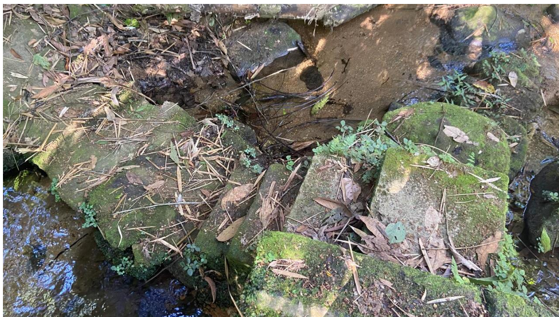
Foto 03 - Escada de acesso
