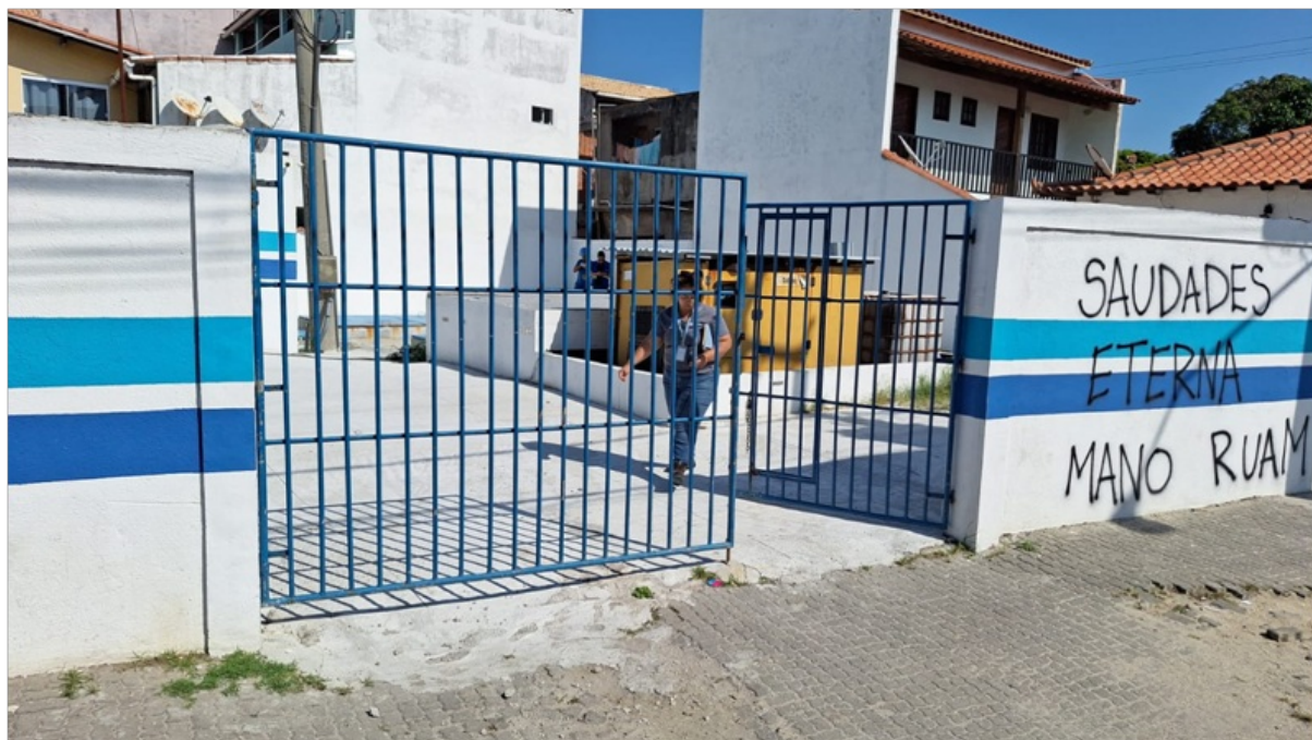
Foto 2 – Vista da entrada da EEE Valão.
