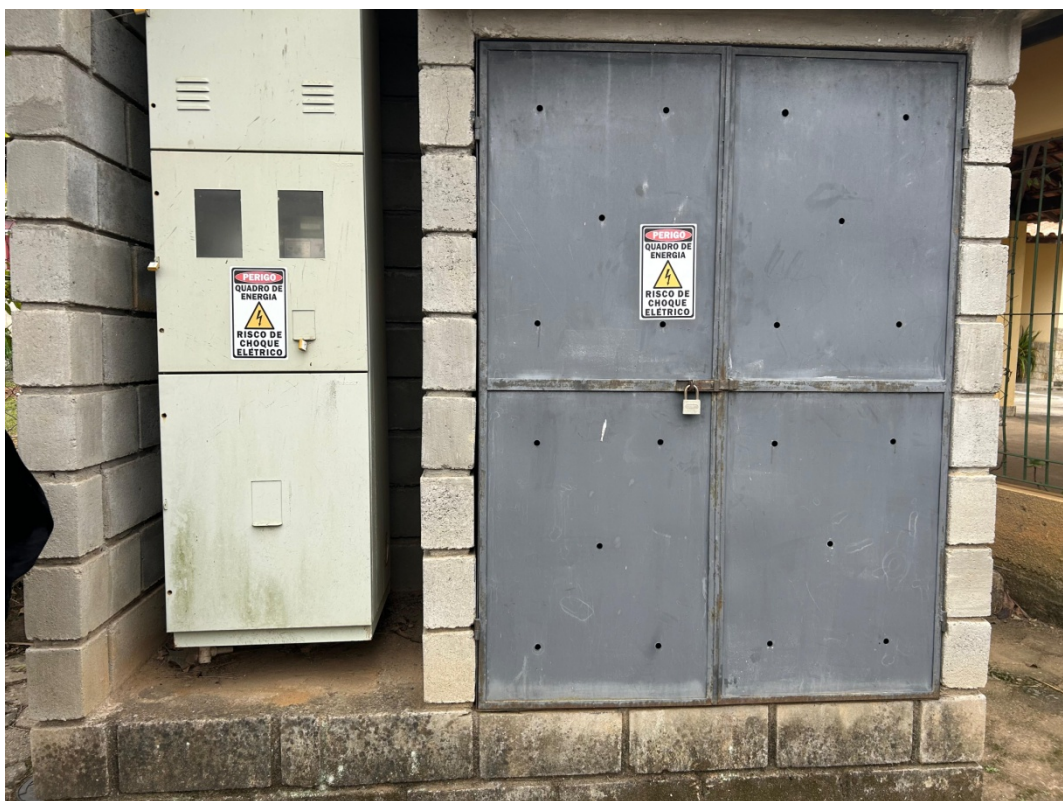
Foto 2 – Abrigo do painel da EEBB desativado
