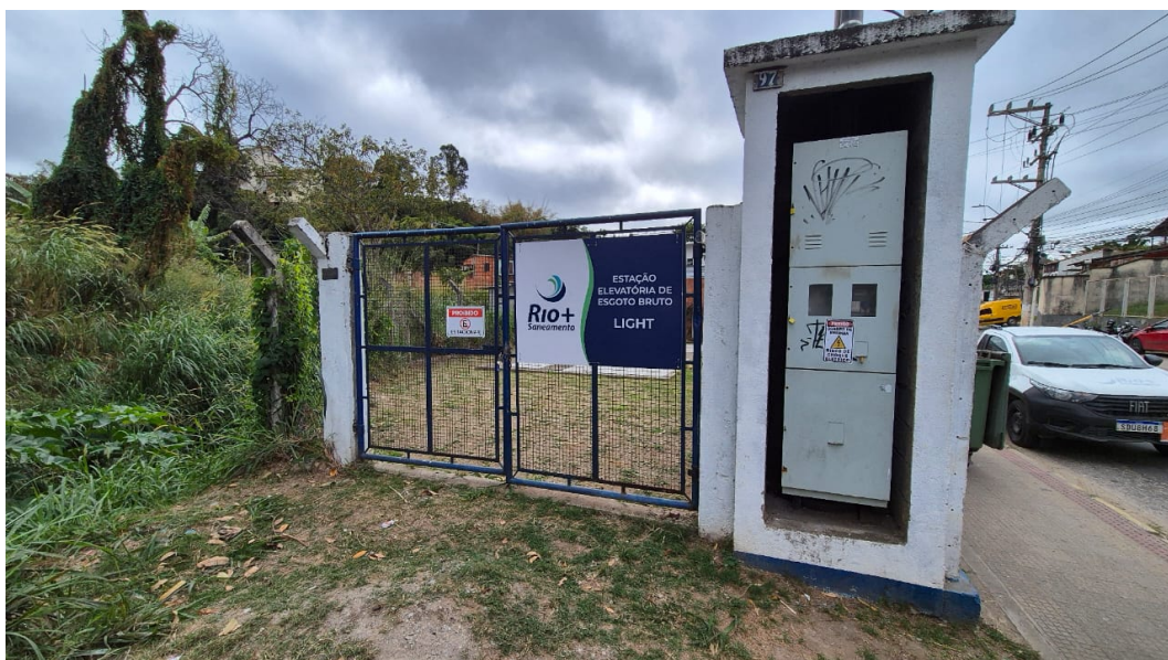
Foto 1 - Entrada da EEEB Light
