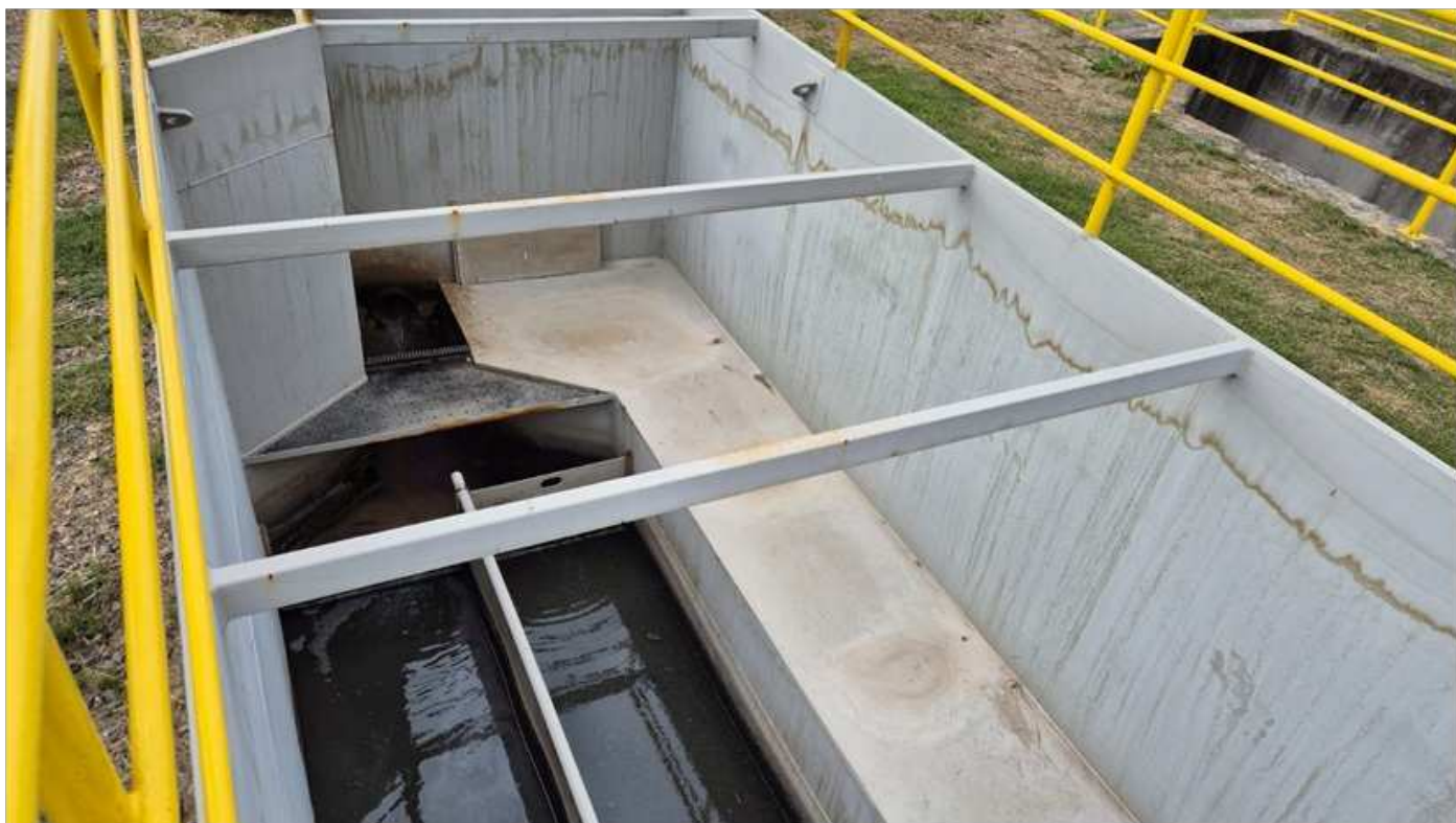
Foto 3 Entrada do esgoto bruto + gradeamento preliminar
