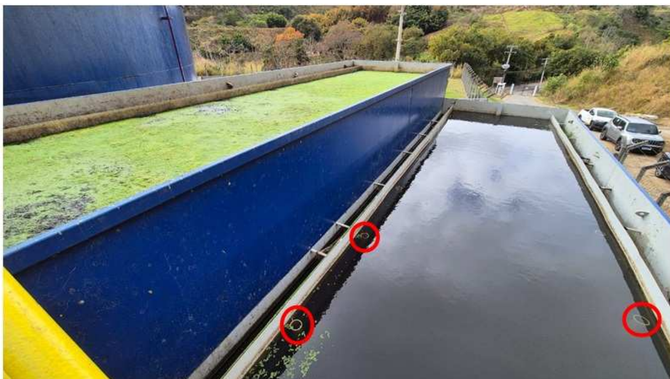
Foto 16 Decantador secundário - tubulações em evidência são para remoção do excesso de material em suspensão
