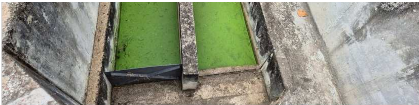
Foto 6 Desarenador desativado
