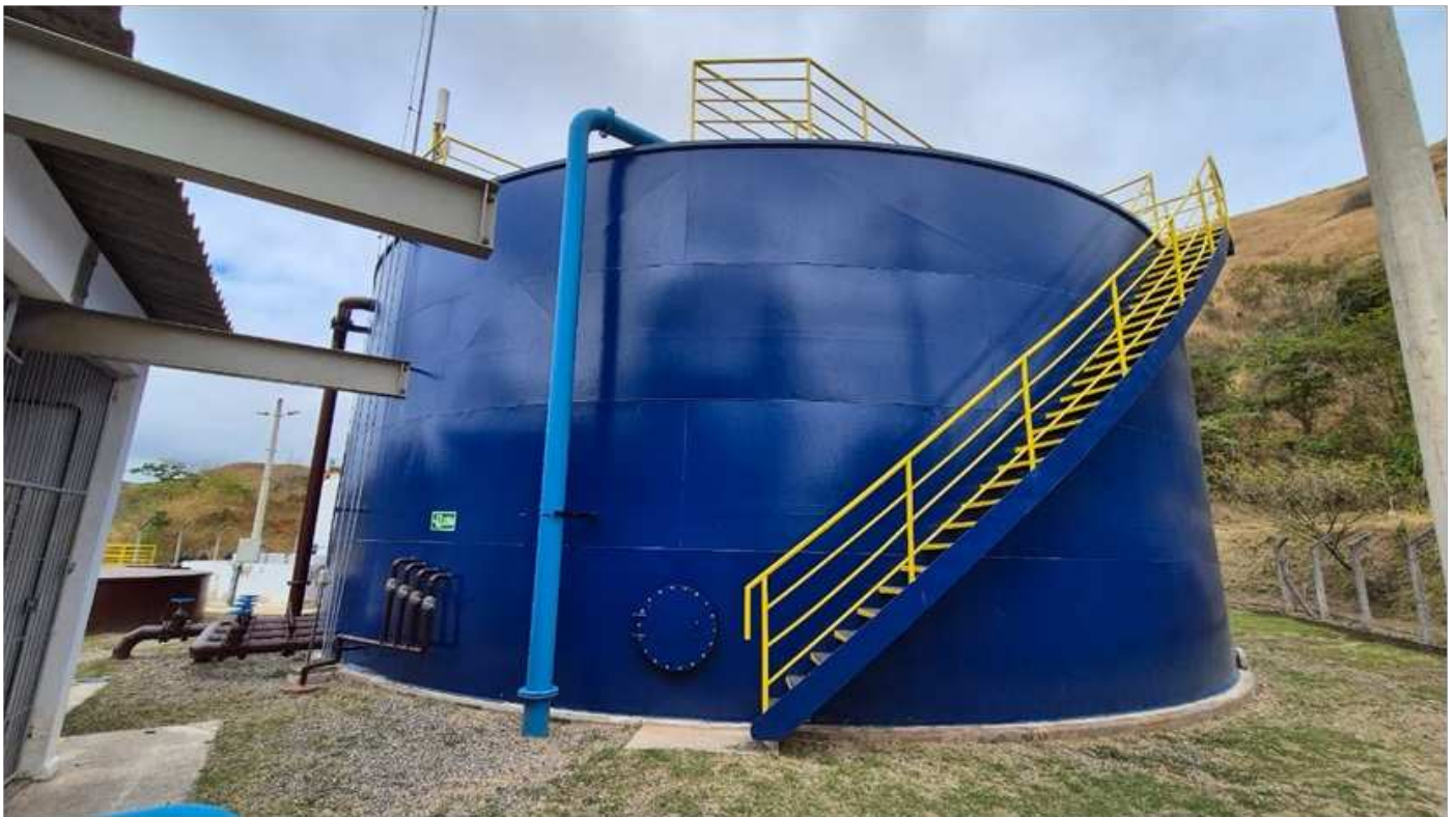
Foto 10 Acesso ao reator UASB
