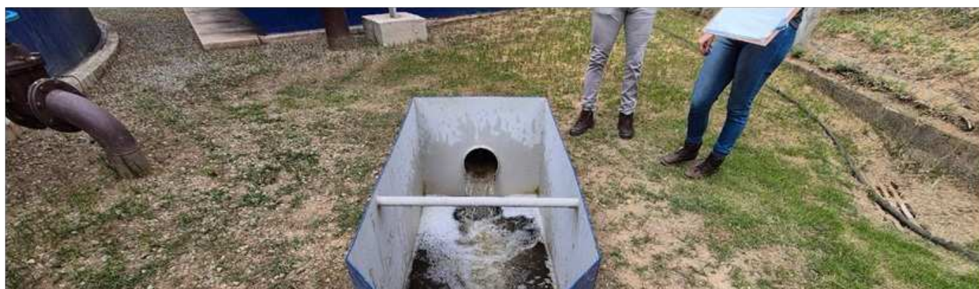
Foto 16 Decantador secundário - tubulações em evidência são para remoção do excesso de material em suspensão
