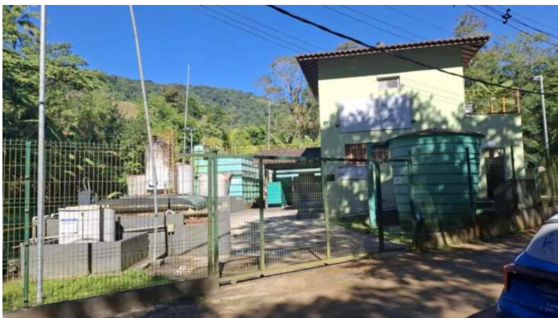
Foto 13 - Entrada da estação; possui cercamento e identificação
