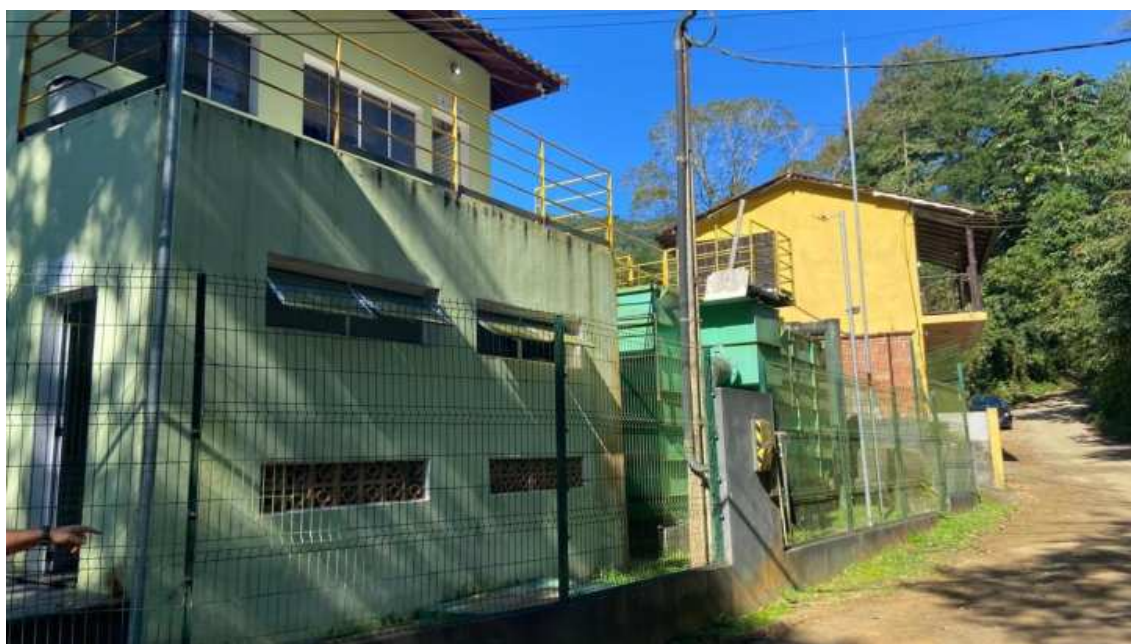
Foto 15 - Cercamento da estação
