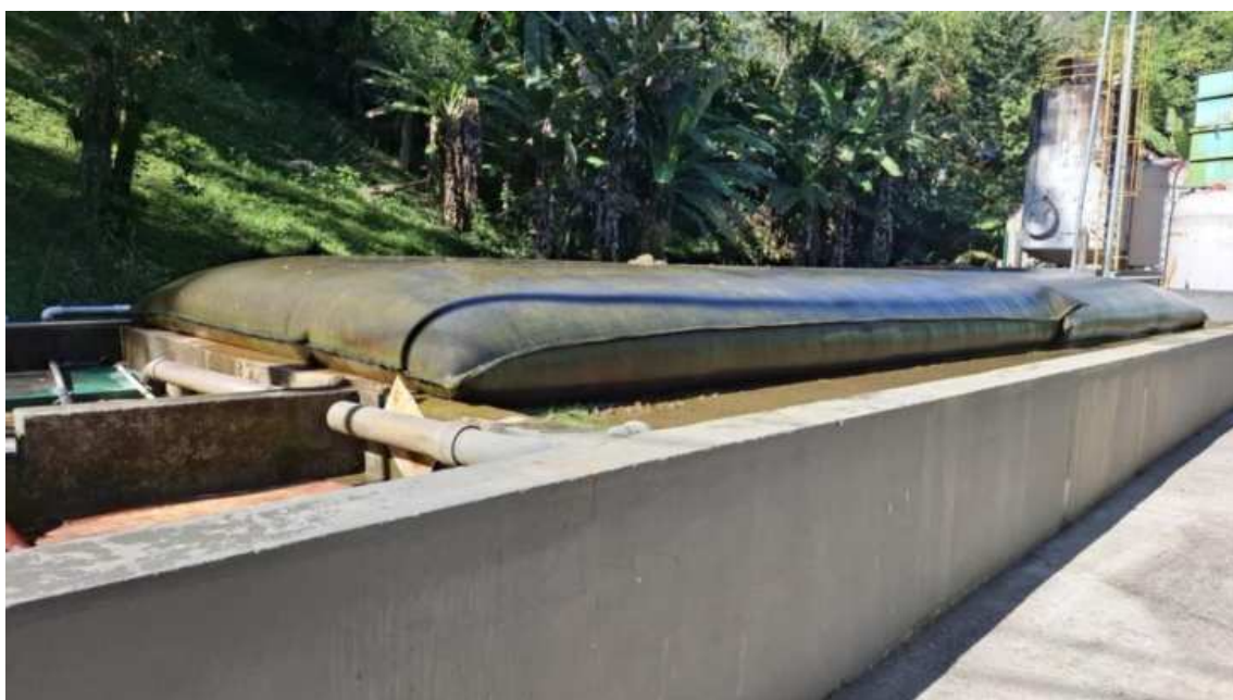
Foto 08 - Geobag para armazenamento do lodo
