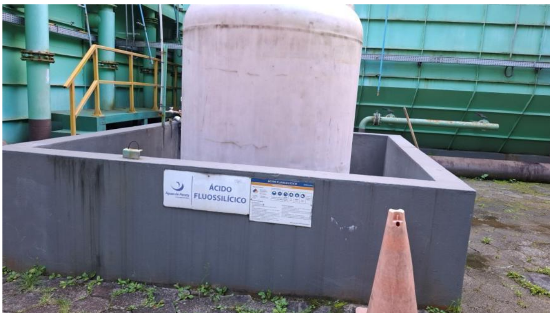
Foto 11 – Ácido Fluossilícico; possui bacia de contenção
