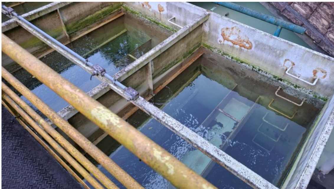
Foto 09 – Filtros; quatro no total com carreira de 12 horas
