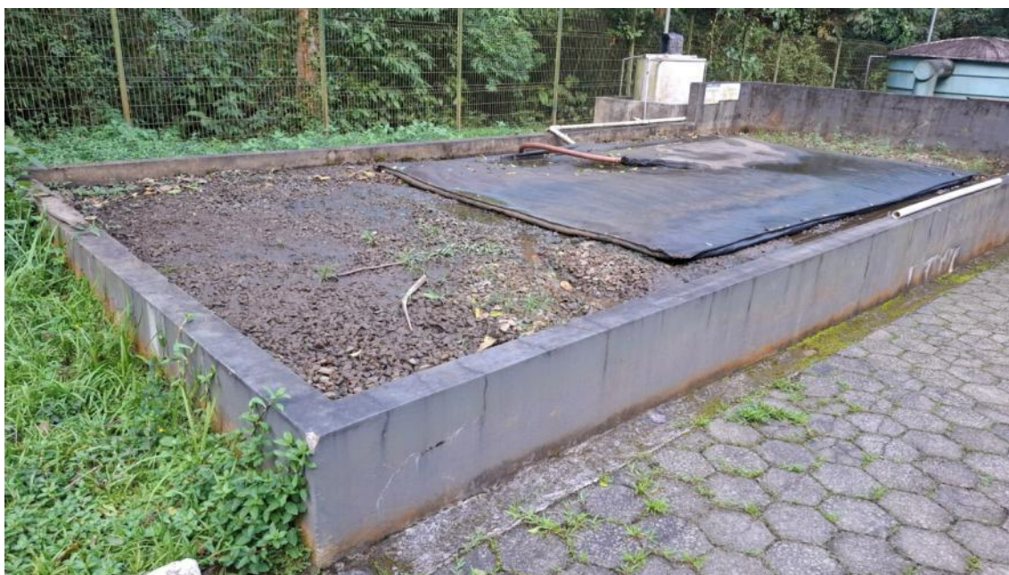
Foto 12 – Geobag para armazenamento do lodo; posteriormente é descartado para aterro sanitário
