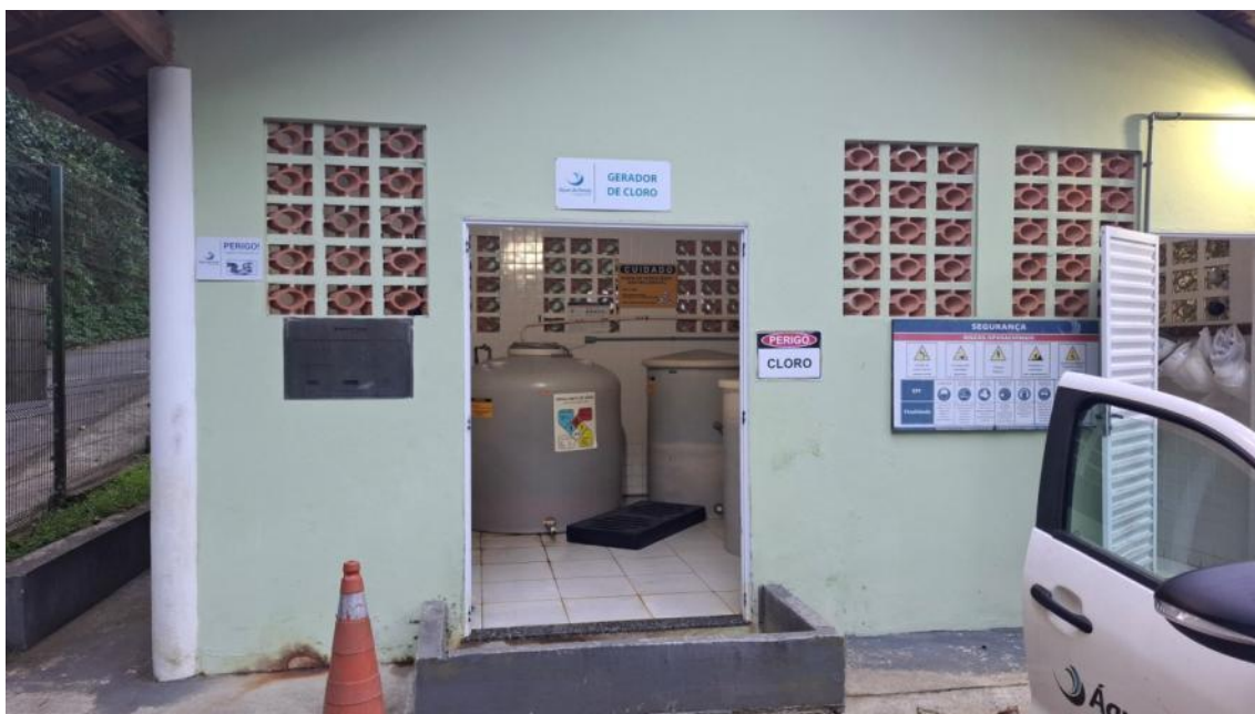
Foto 13 – Gerador de cloro; hipoclorito é produzido a partir de solução de salmora
