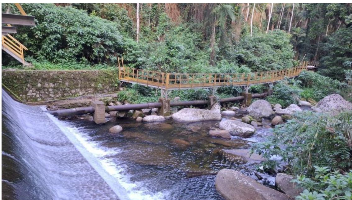
Foto 02 – Adução por gravidade até a ETA Pedra Branca com caixa de areia ao final da passarela
