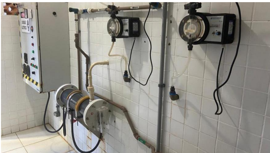
Foto 14 – Equipamento para eletrólise e produção do hipoclorito
