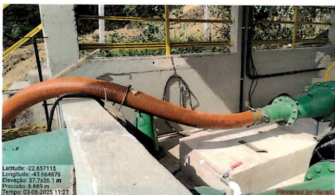
Foto 3: Conexão da bomba submersível provisória.
