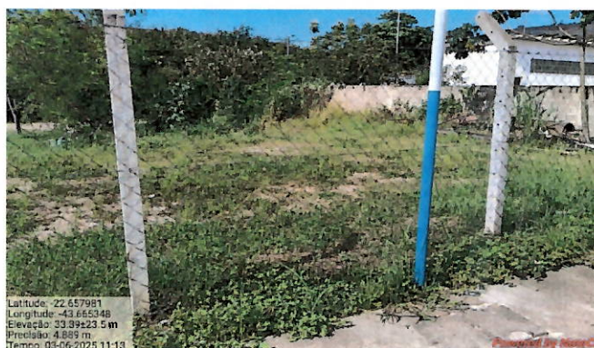
Foto 5: Cercamento reparado (verificado em vistoria anterior).
