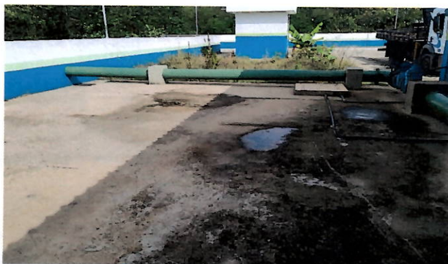
Foto 26: Área do reservatório.
