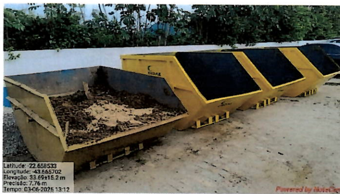
Foto 44: Caçambas de armazenamento de lodo desidratado.
