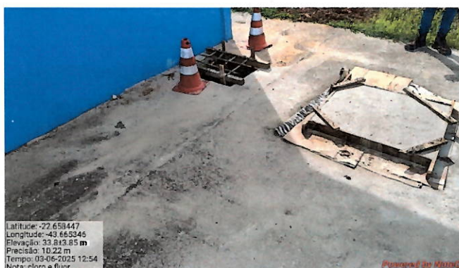
Foto 46: Local sendo preparado para instalação do grupo gerador.
