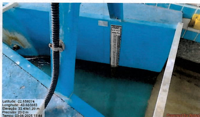
Foto 9: Régua medidora de vazão.
