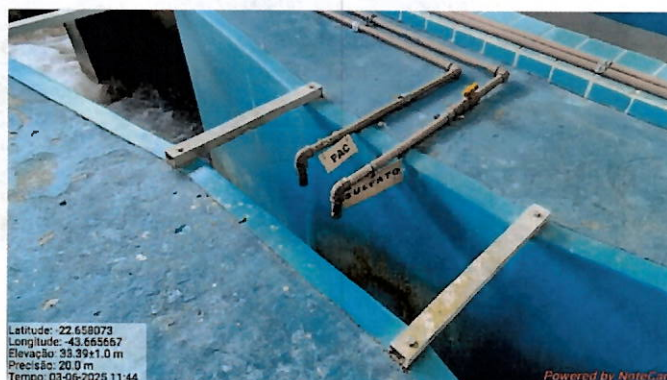
Foto 11: Aplicação de coagulante.
