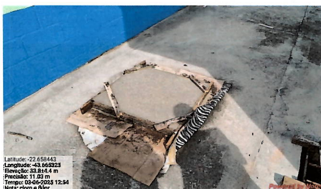
Foto 47: Local sendo preparado para instalação do grupo gerador.
