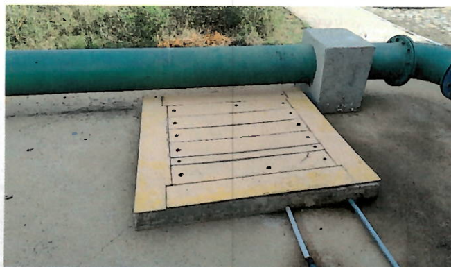
Foto 27: Tampa de inspeção.
