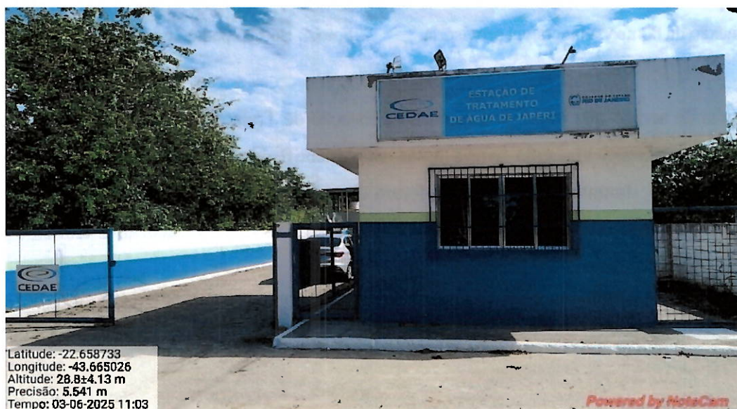
Foto 7: Entrada da ETA.
