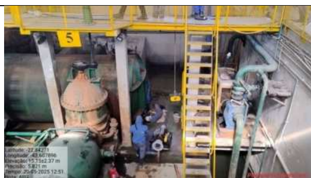
Foto N° 18 – Instalação de válvula de gaveta 5ª linha
