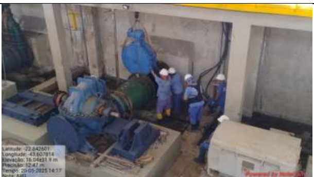
Foto Nº 24- Substituição de válvula borboleta do recalque do grupo 4
