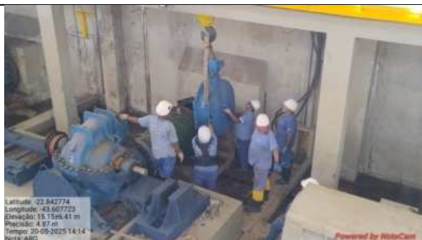
Foto Nº 23- Substituição de válvula borboleta do recalque do grupo 4
