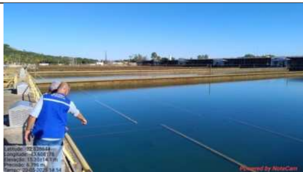
Foto N° 25 – Verificação das instalações dos raspadores nos tanque de decantação VETA
