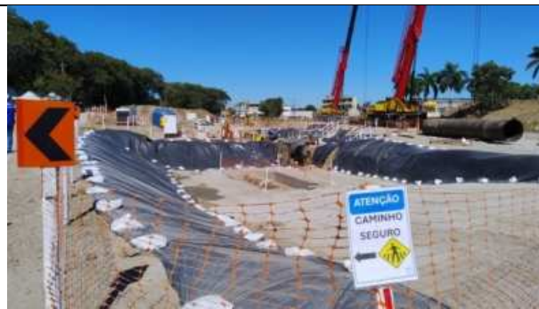
Foto Nº 2 – Vista geral do canteiro de obras
