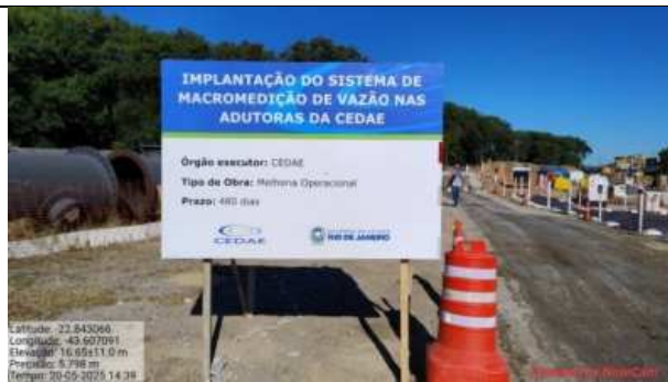
Foto Nº 1 – Placa de identificação das obras
