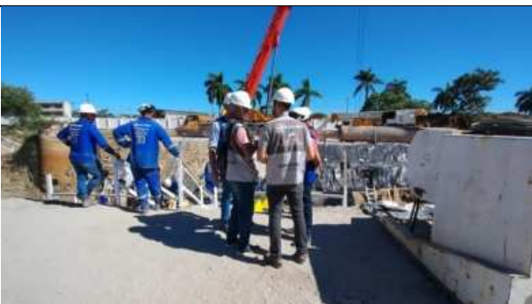
Foto N° 30 – Técnicos da CEDAE e Equipe de Fiscalização da AGENERSA
