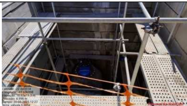
Foto N° 15 – Instalação de válvula de gaveta na 5ª linha
