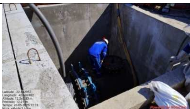
Foto N° 17 – Instalação de válvula borboleta na 5ª linha
