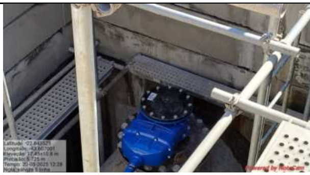
Foto N° 16 – Instalação de válvula de gaveta na 5ª linha
