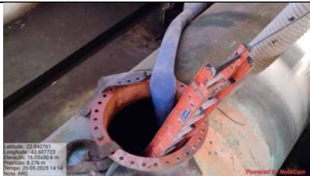
Foto Nº 21 – Inspeção interna do barrilete do ARG.
