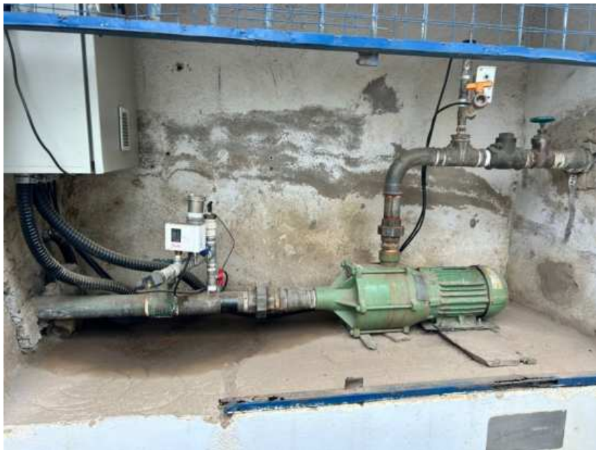
Foto 2 - Visualização do interior do abrigo
