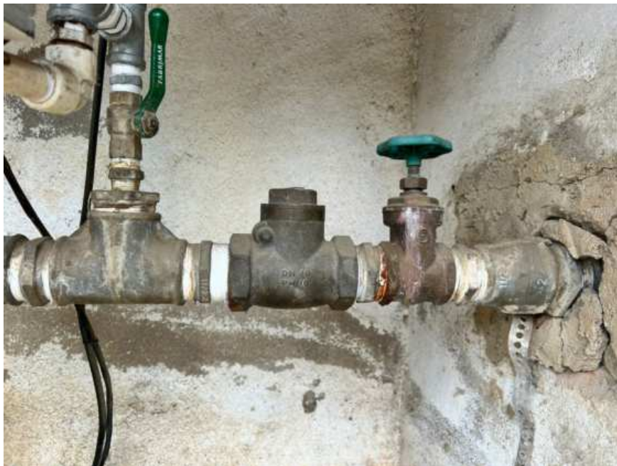
Foto 3 – Válvula de retenção
