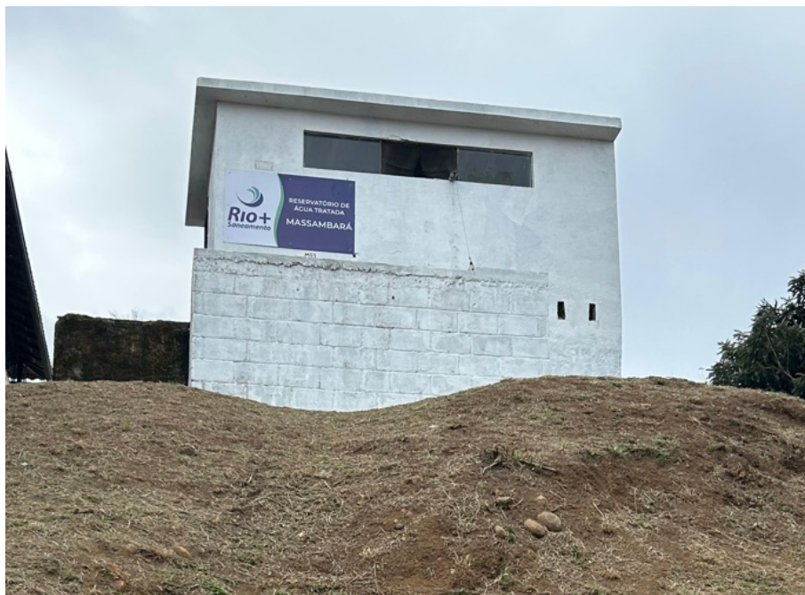
Foto 1 - Vista do Reservatório com identificação
