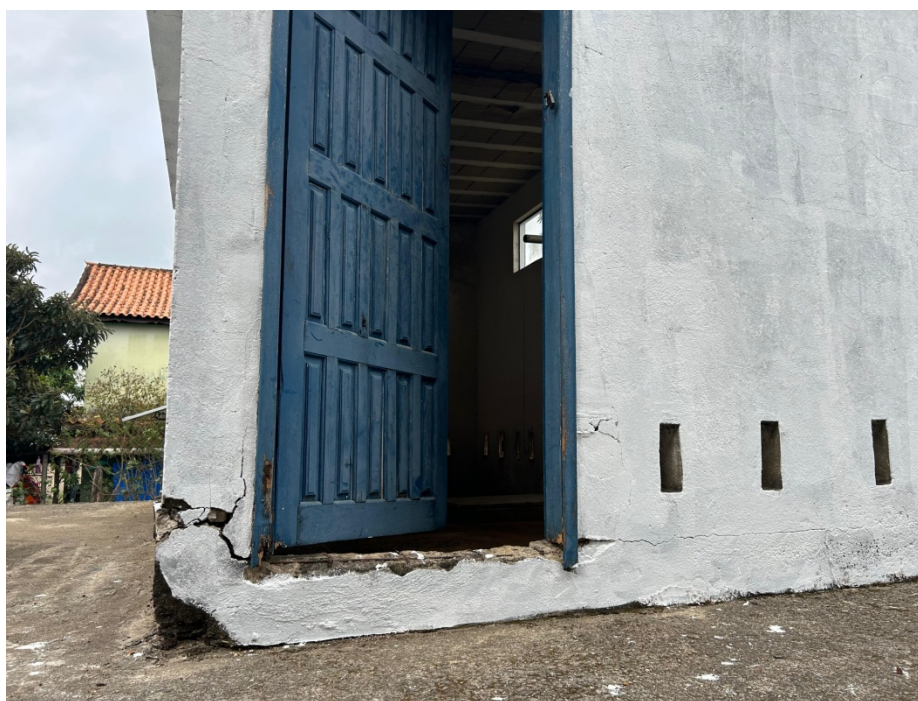
Foto 4 - Acesso ao reservatório com porta aberta
