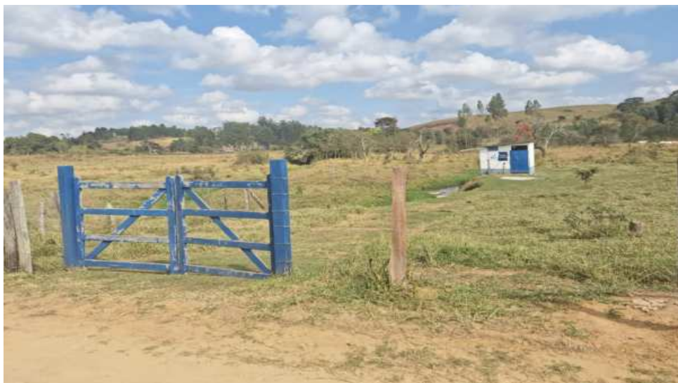
Foto 1 – Acesso à captação
