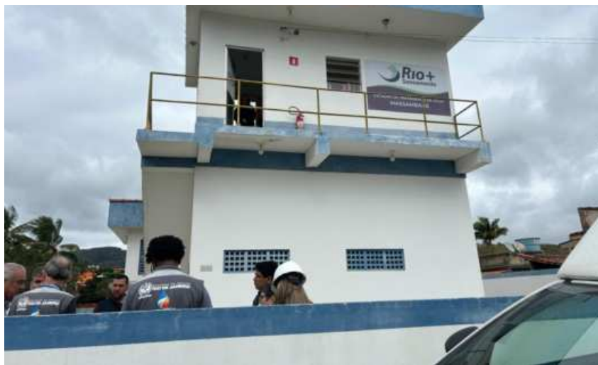
Foto 7 - Identificação da ETA Massambará
