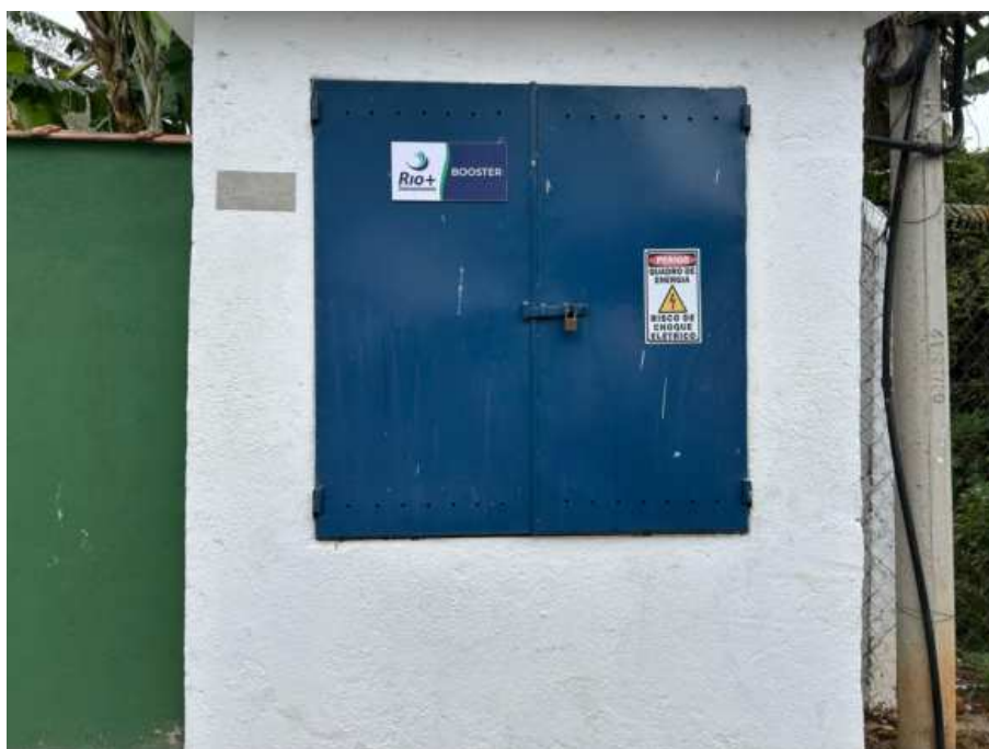
Foto 18 – Abrigo da EEAT com identificação
