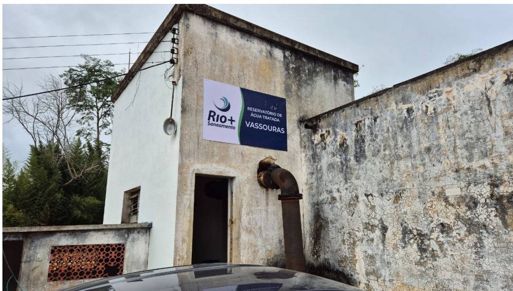
Foto 1 - Vista do Reservatório com identificação e sem porta
