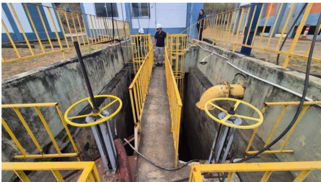
Foto 4 - Escadas de acesso providas de proteção
