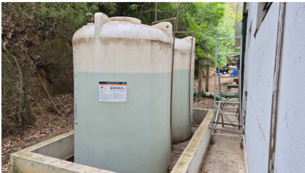
Foto 21 - Tanque de armazenamento do Hipoclorito de Sódio
