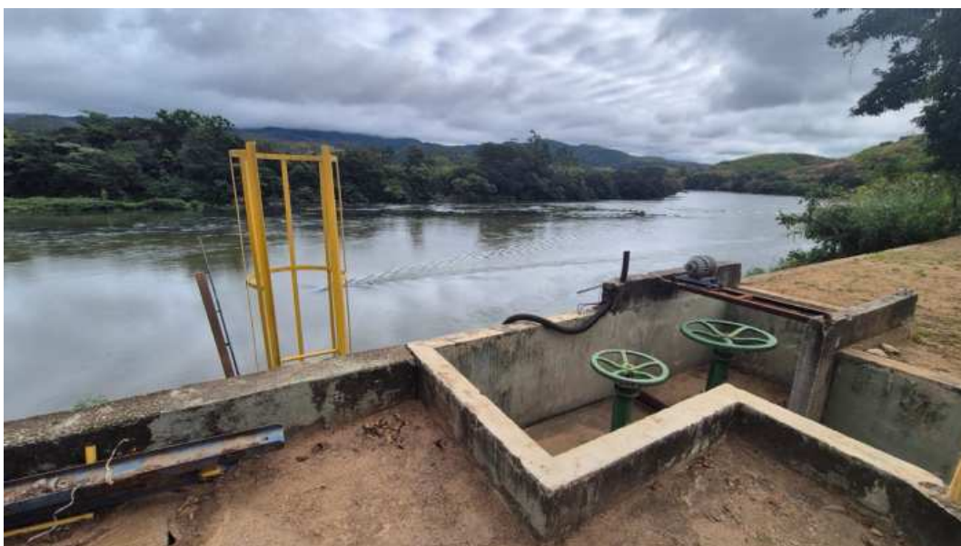
Foto 2 - Captação no Rio Paraíba do Sul
