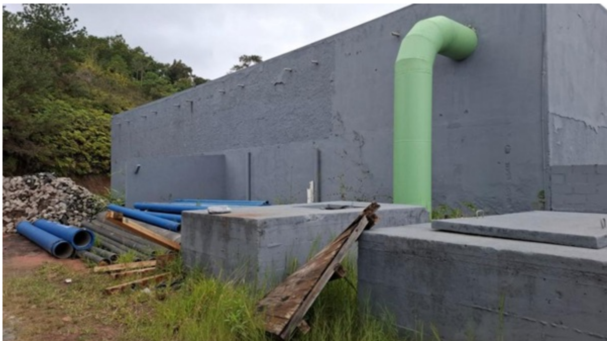
Foto 03 – Tubulação que abastece o reservatório
