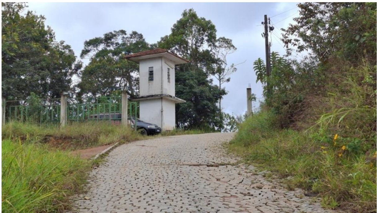
Foto 01 – Acesso do reservatório com portão
