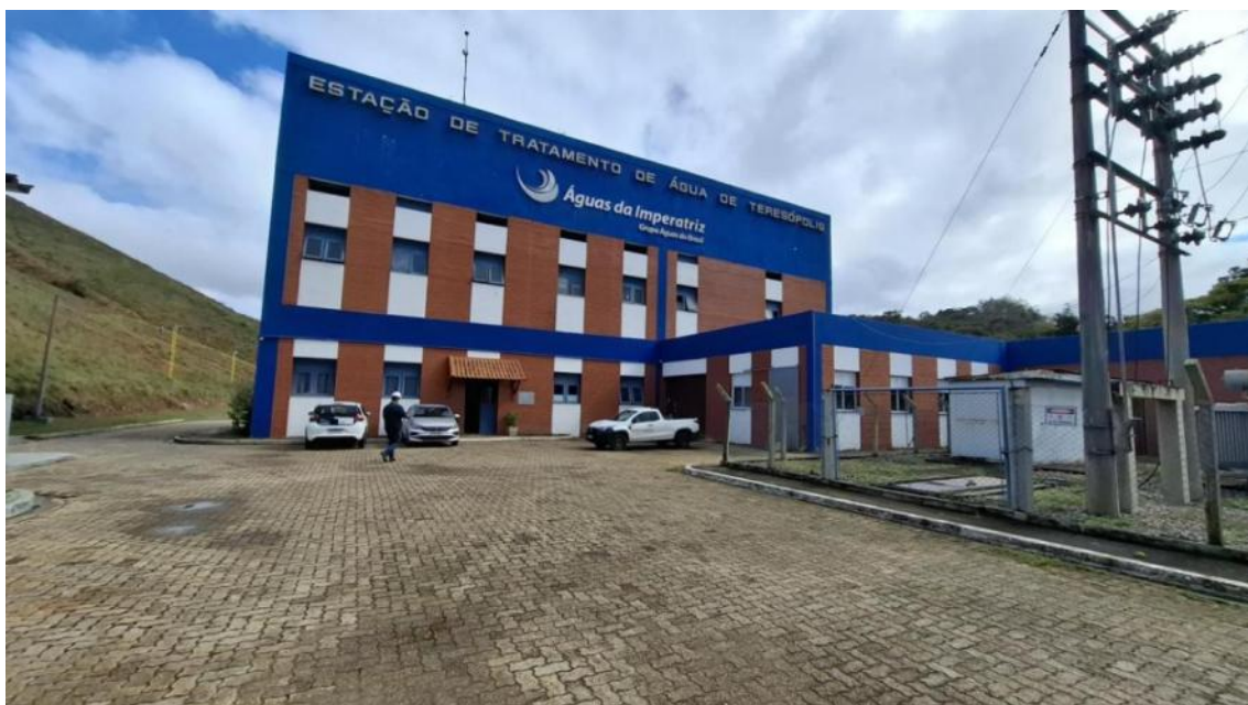
Foto 01 - Entrada da ETA
