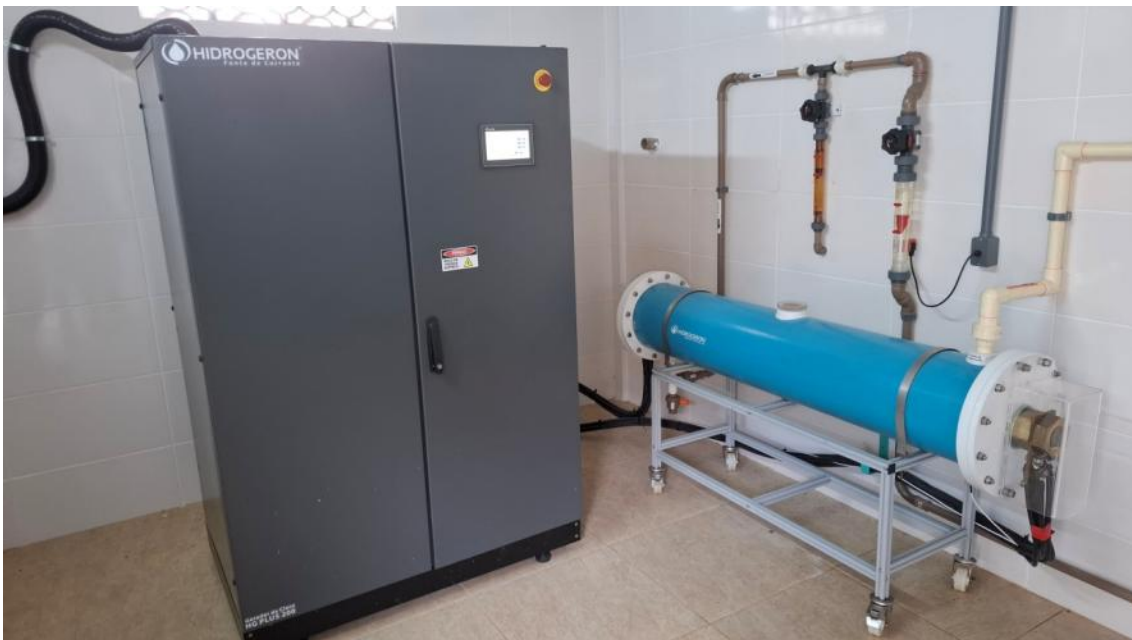
Foto 11 – Equipamento para produção de hipoclorito através de eletrólise
