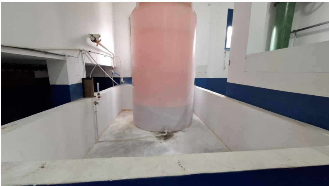
Foto 11 – Equipamento para produção de hipoclorito através de eletrólise
