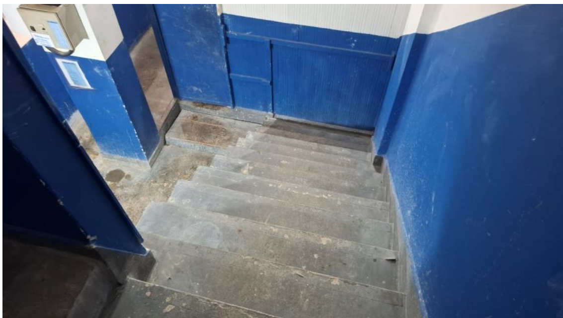
Foto 02 – Escada da estação; falta guarda-corpo
