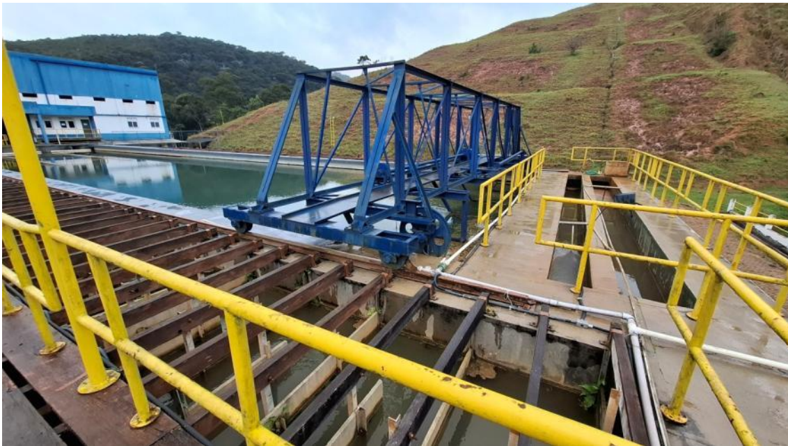
Foto 07 – Máquina para limpeza dos decantadores; foi informado que nunca entraram em operação
