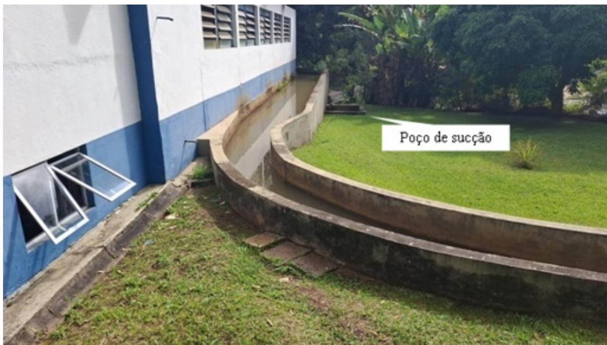
Foto 09 – Poço de sucção
