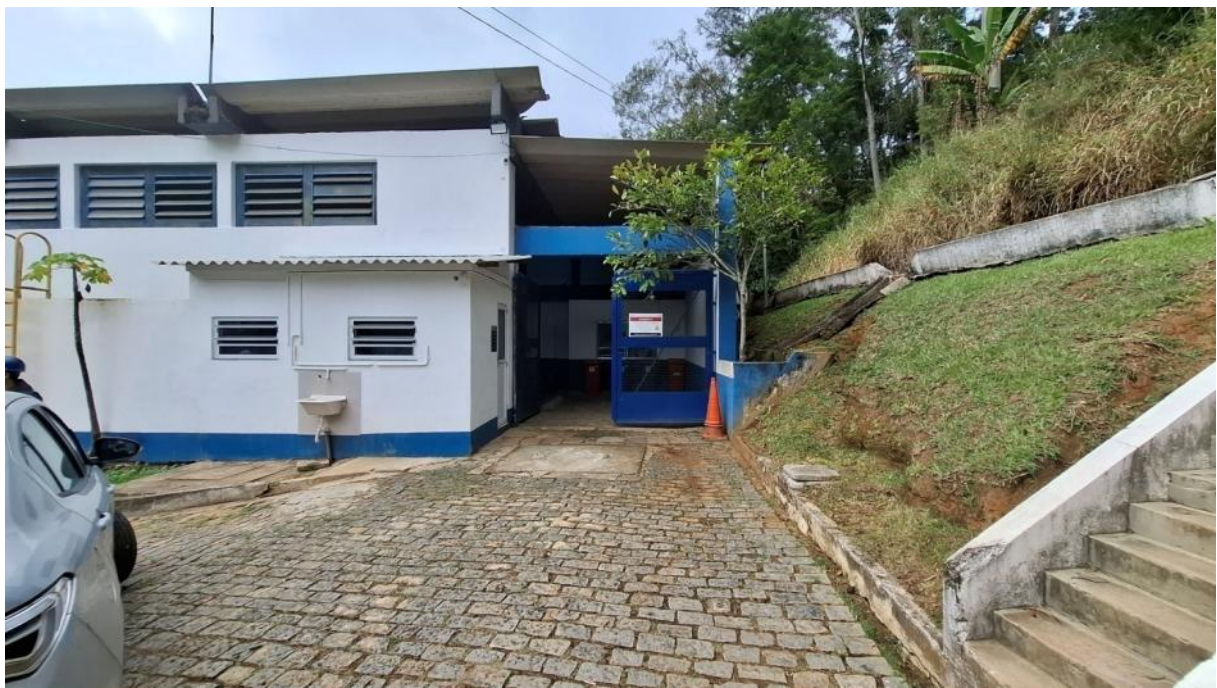
Foto 03 – Acesso ao abrigo de alvenaria
