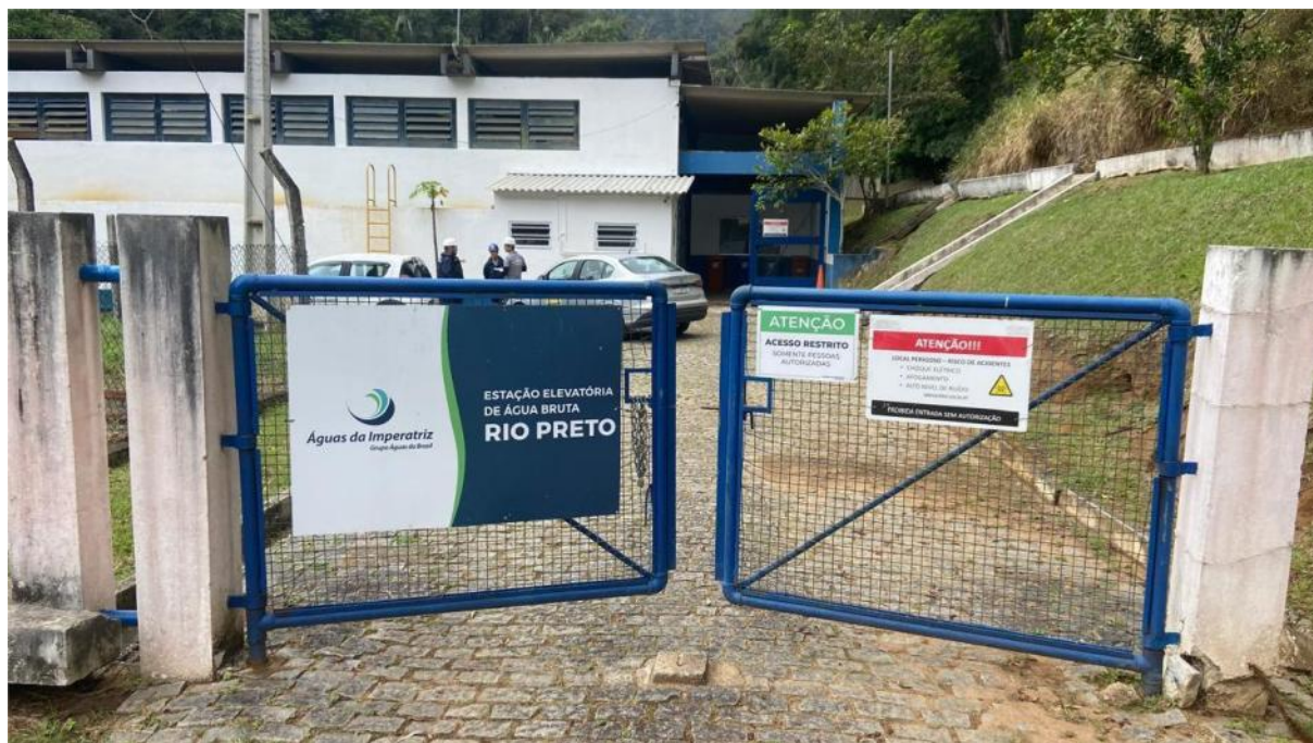
Foto 01 – Entrada da estação
