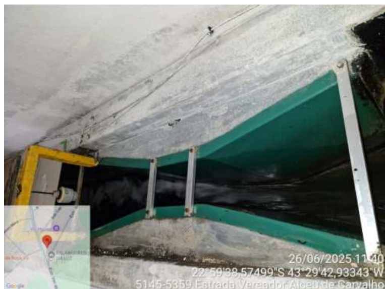
Foto 06 – Calha Parshall de saída
