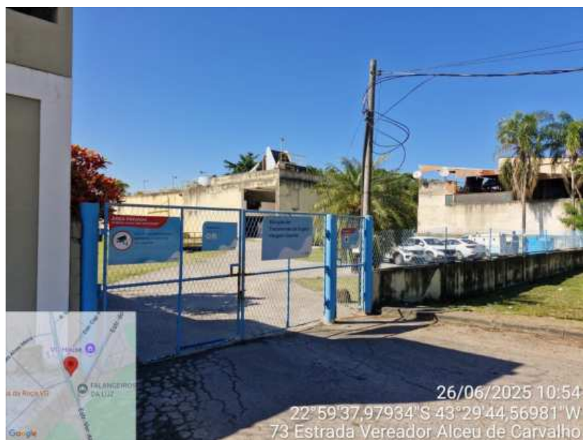
Foto 21 – Entrada da ETE
