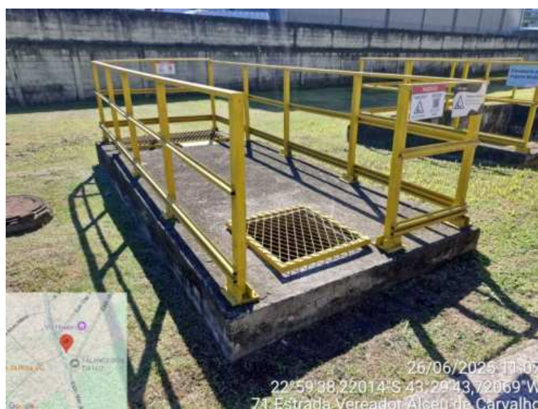
Foto 01 – Caixa de chegada
