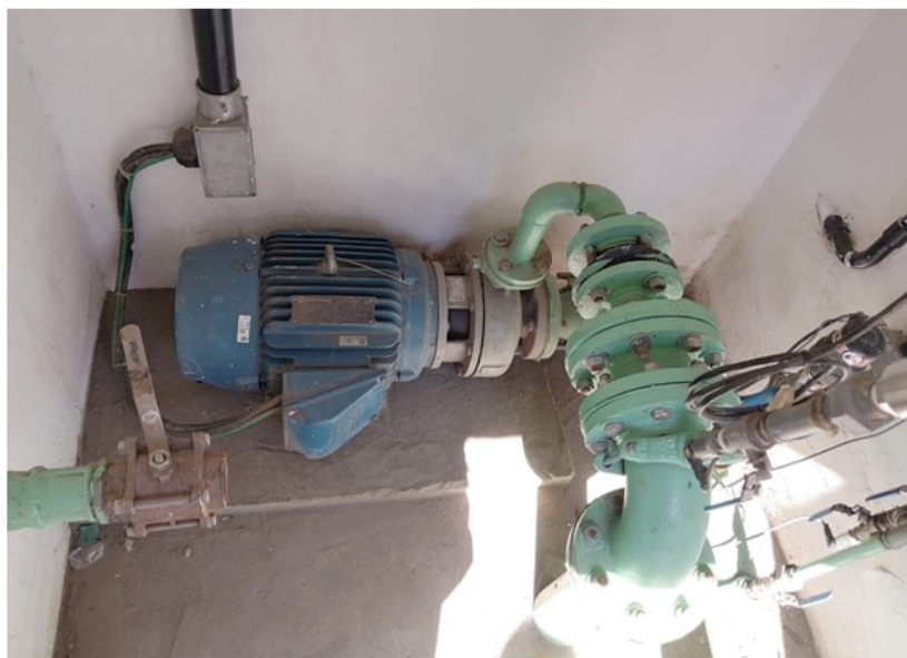
Foto 3 – Abrigo com bom espaço interno e boa iluminação natural
