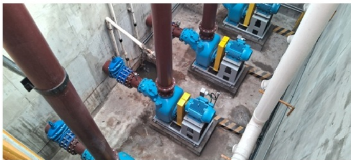
Foto 8 e 9 – Conjuntos moto-bomba e recalque com válvulas de retenção
