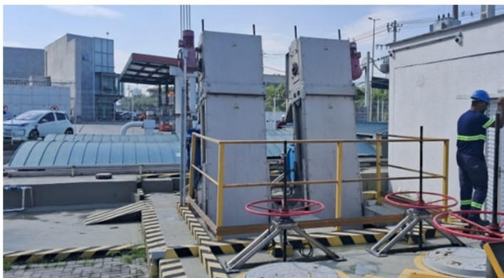
Foto 2 e 3 – Gradeamento mecanizado/ descarte de resíduos nos containers.
