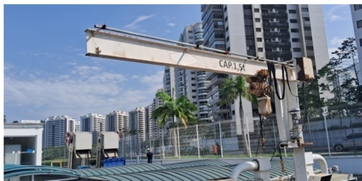
Fotos 12 e 13 – Monovia com guincho, sistema de ventilação forçada e cobertura móvel da EEE
