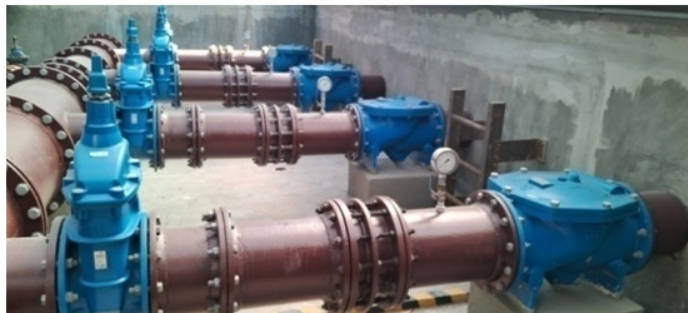
Foto 8 e 9 – Conjuntos moto-bomba e recalque com válvulas de retenção
