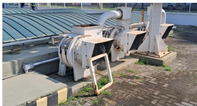
Fotos 12 e 13 – Monovia com guincho, sistema de ventilação forçada e cobertura móvel da EEE
