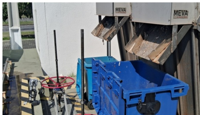
Foto 2 e 3 – Gradeamento mecanizado/ descarte de resíduos nos containers.
