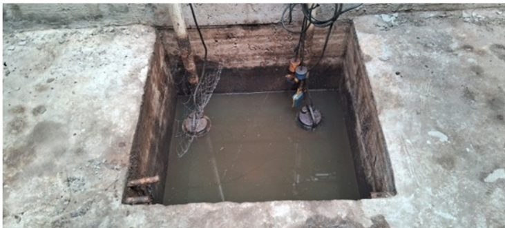
Foto 6 e 7 – Poço de drenagem com bomba, extintor de incêndio
