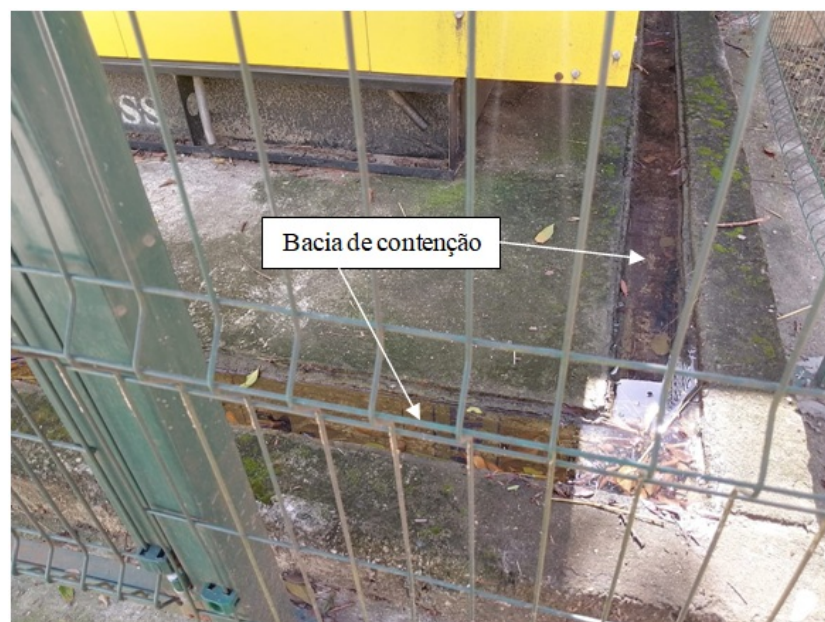
Foto 4 – Bacia de contenção
