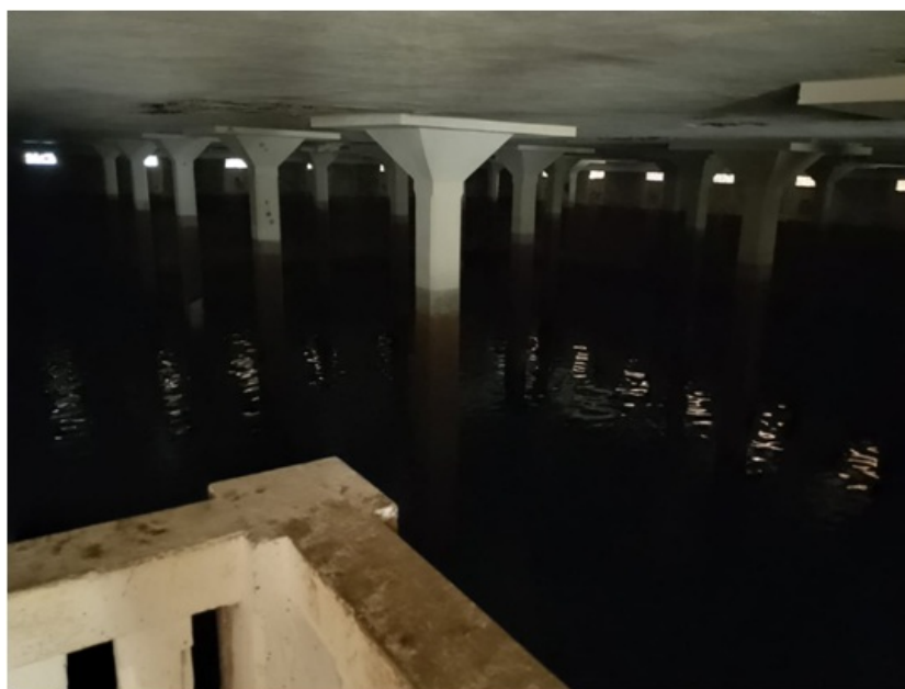
Foto 14 – Nível de água do reservatório
