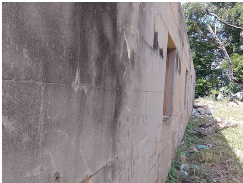
Foto 9 – Vista lateral do reservatório
