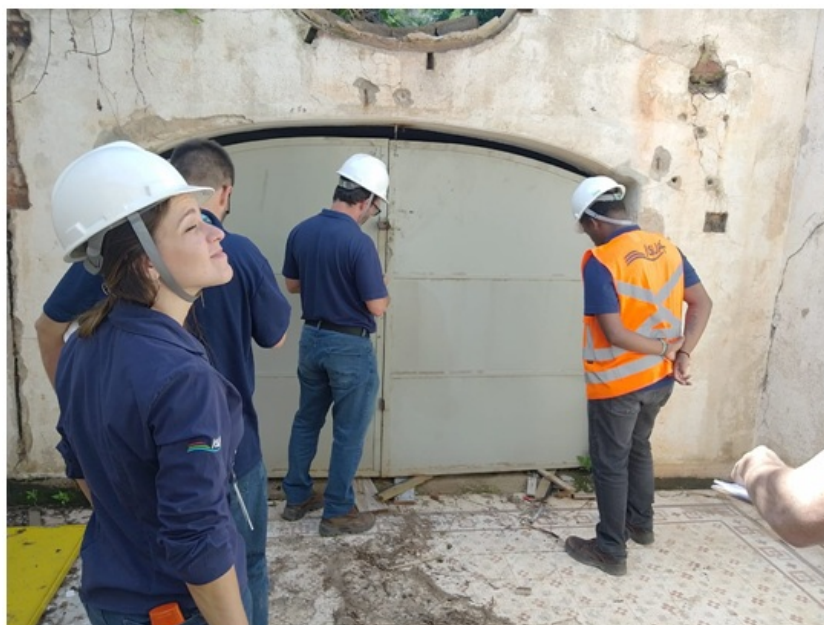
Foto 4 – Entrada da câmara
