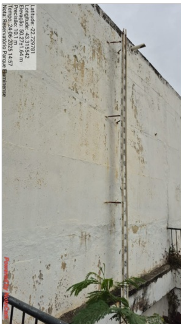
Foto 7: Mangueira de nível
