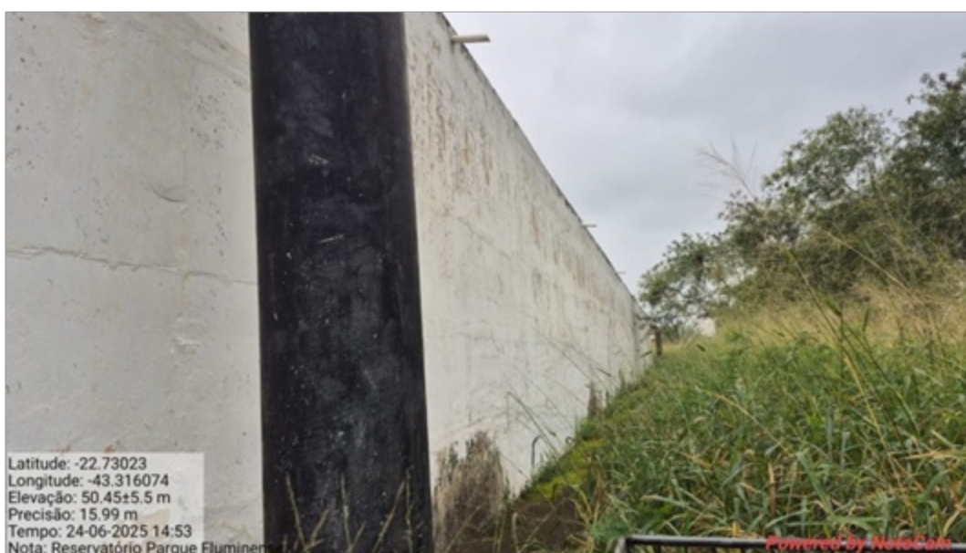
Foto 5: Fachada reservatório com tubulações de chegada
