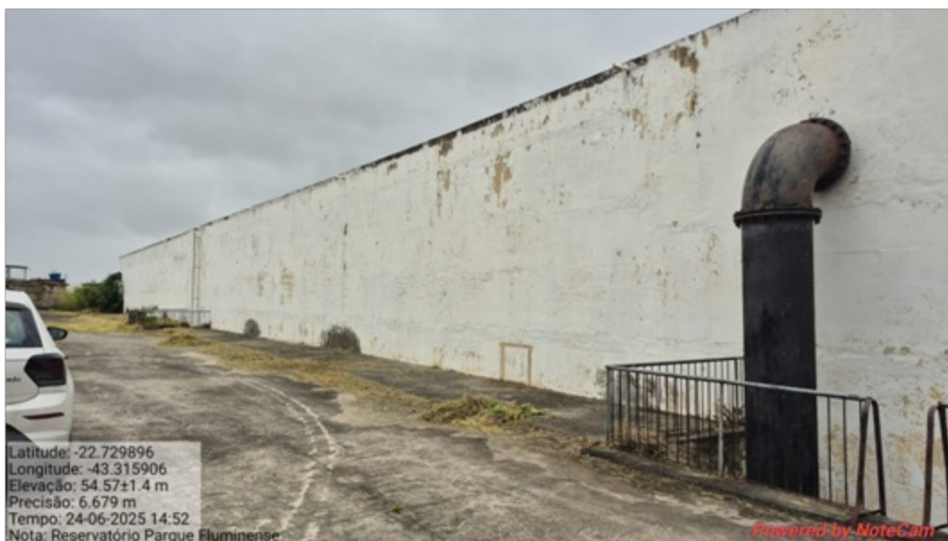
Foto 4: Fachada reservatório em evidência tubulação extravasor
