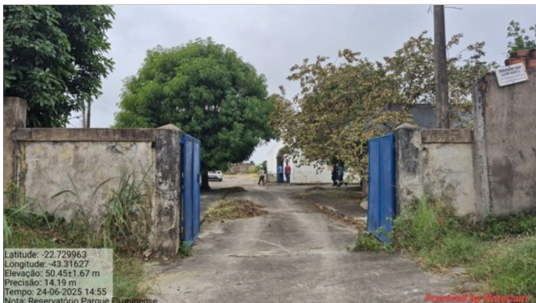
Foto 1: Acesso a área do reservatório
