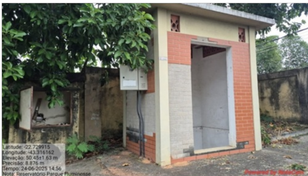
Foto 12: Edificação na área da unidade
