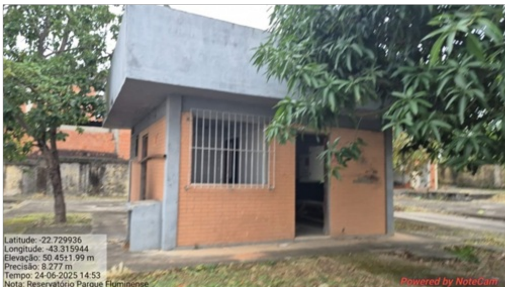
Foto 13: Edificação na área da unidade
