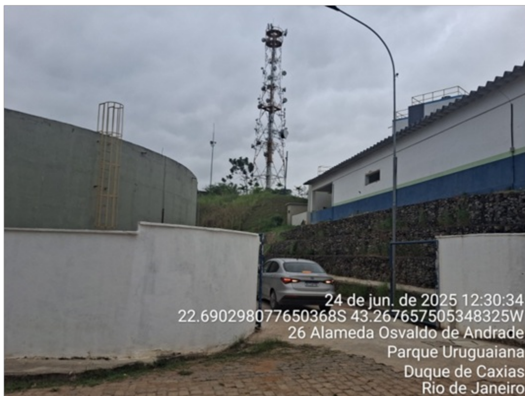
Foto 1: Acesso a área do reservatório
