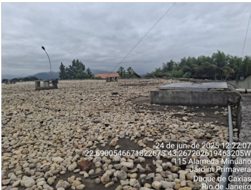
Foto 4: Laje superior com visita em evidência
