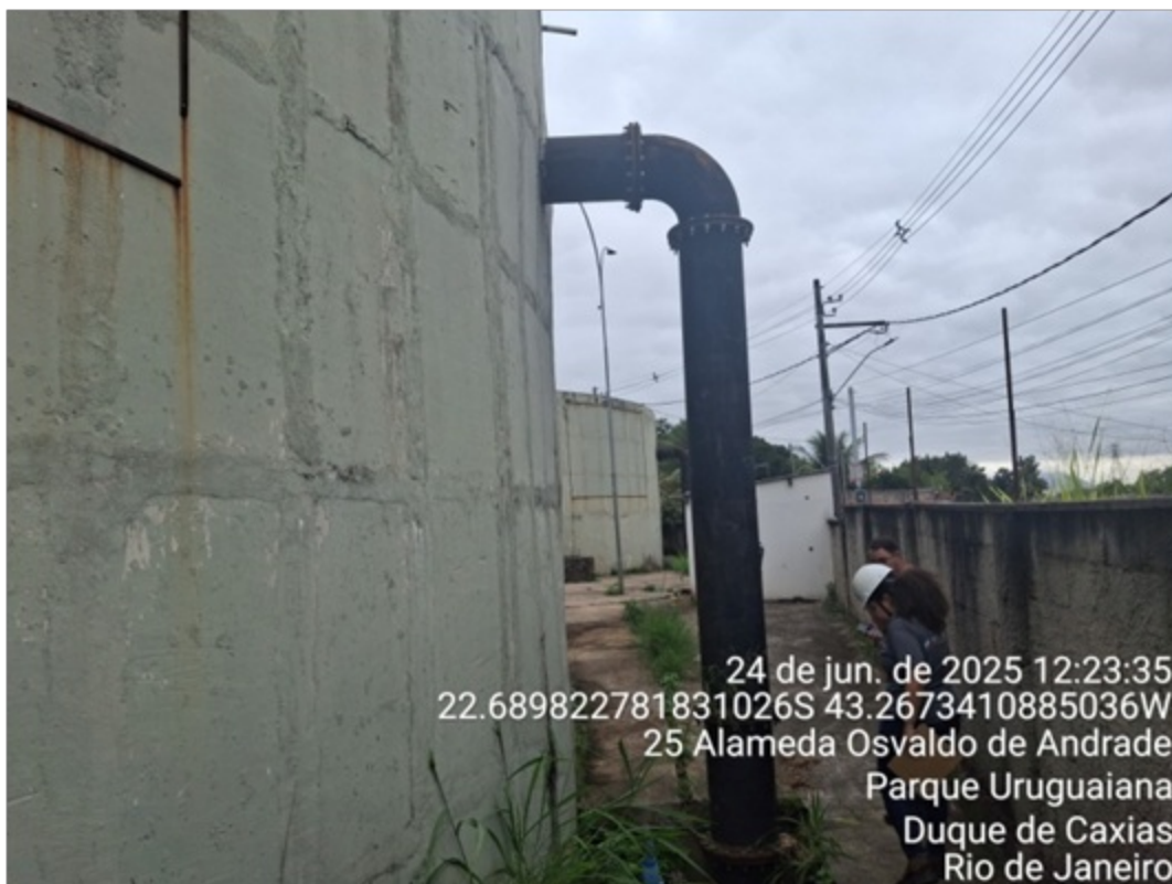
Foto 5: Tubulação extravassor
