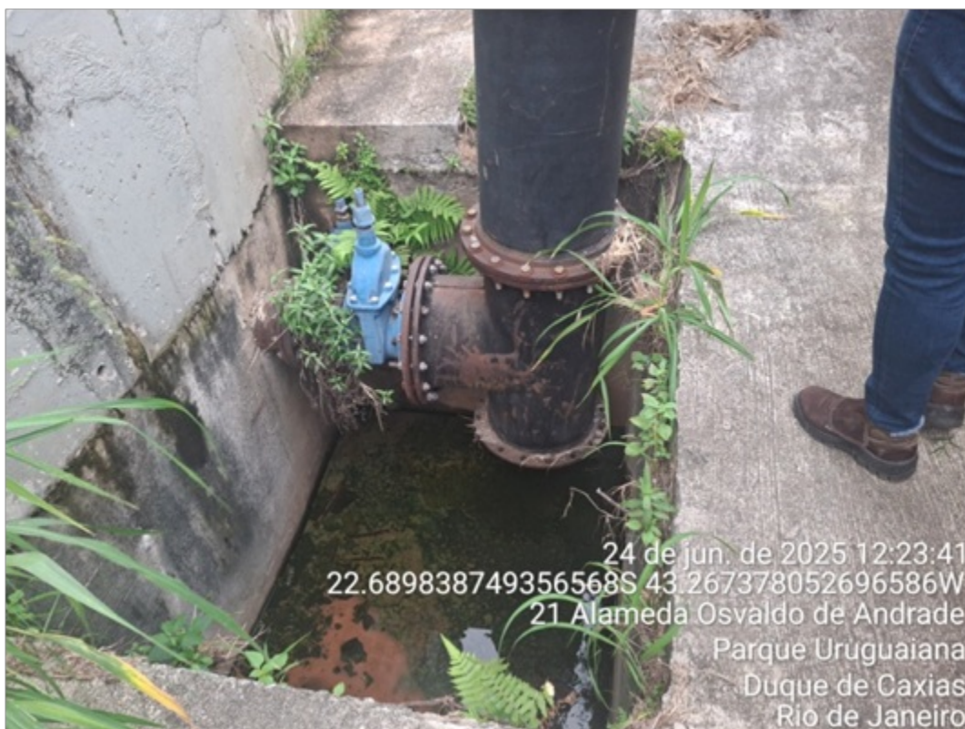
Foto 6: Válvula extravassor
