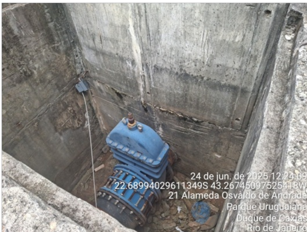
Foto 11: Barrilete de chegada com datalogger
