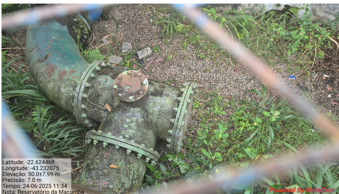
Foto 4. Barilete do Reservatório cercado
