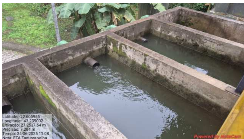
Foto 5. Etapa de filtração da ETA velha
