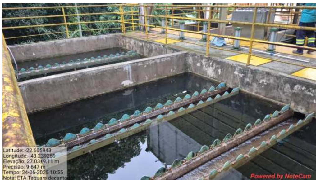
Foto 3. Etapa de decantação da ETA nova
