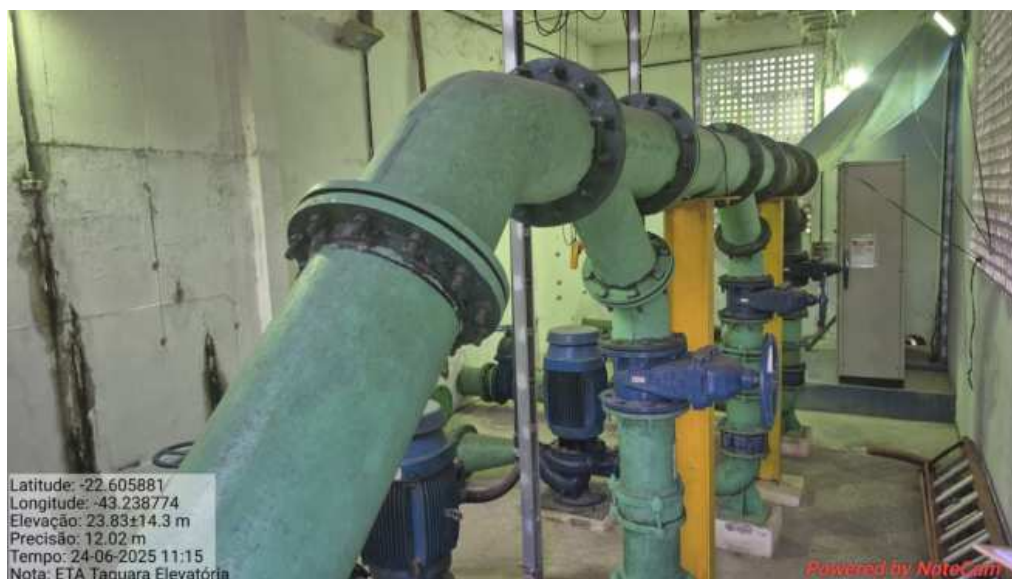
Foto 14. Elevatória de água tratada
