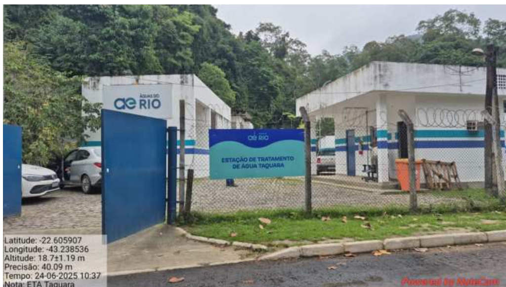
Foto 6. Entrada da Estação de Tratamento de Água Taquara, com prédio administrativo e abrigo dos insumos e gerador de cloro à frente
