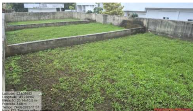
Foto 12. Tanques de lodo
