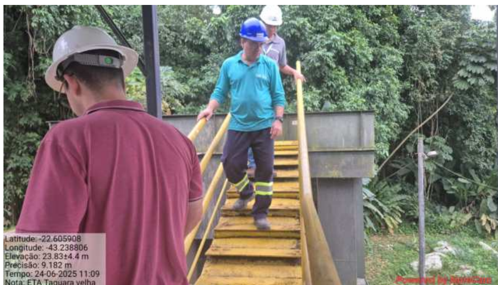
Foto 7. Escada da etapa do tanque de decantação da ETA velha oxidando
