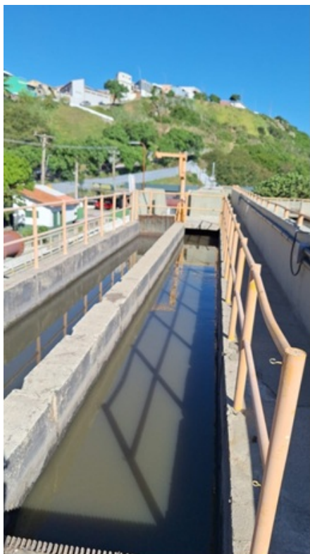
Fotos 6 e 7 – Gradeamento / Desarenador com duas câmaras; Calha Parchall com sensor ultrassônico.
