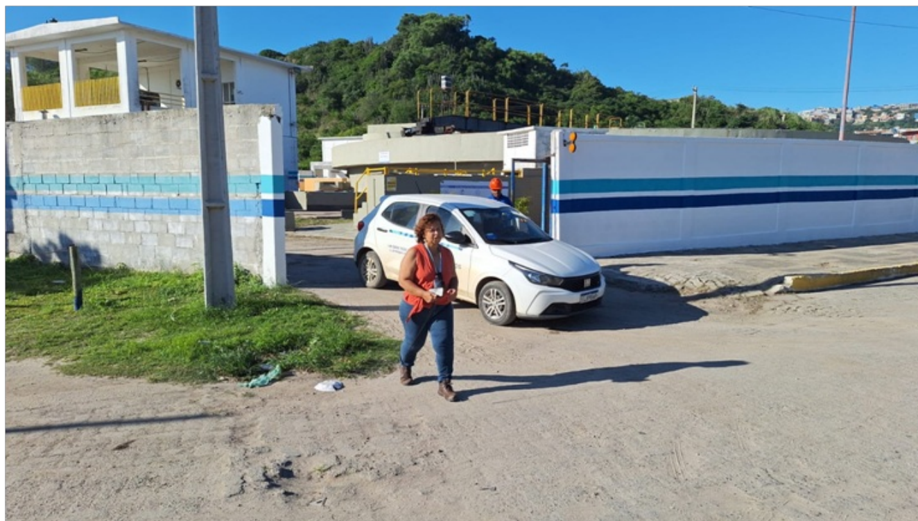
Foto 2 – Entrada da ETE Arraial do Cabo
