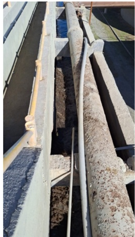
Foto 10 e 11 – Recirculação do lodo do decantador para o tanque de aeração; Dosagem do PAC na saída do tanque de aeração para otimizar a sedimentação no decantador.
