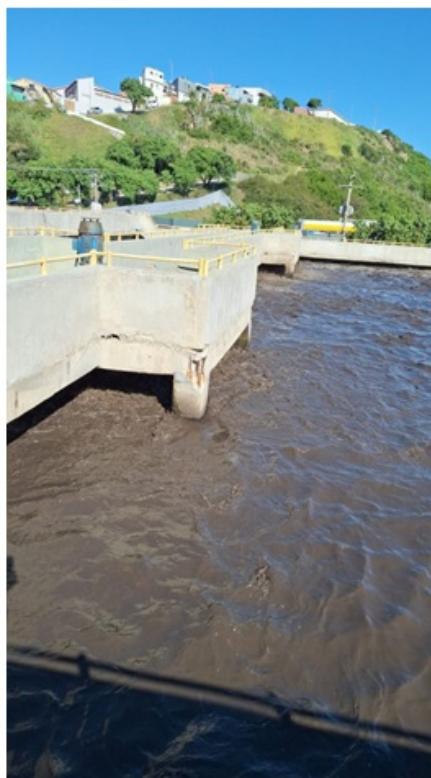
Fotos 8 e 9 – Tanque de aeração com 7 aeradores em operação; Estrutura das passarelas necessitando de reparo.
