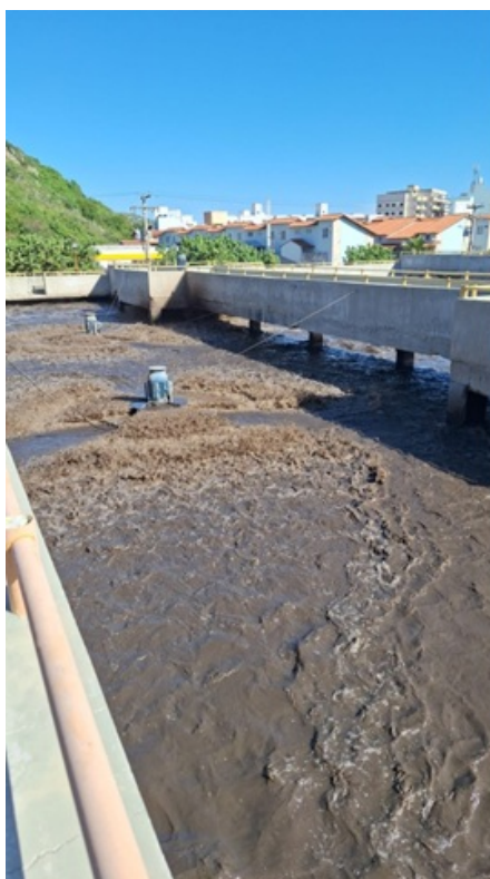
Fotos 8 e 9 – Tanque de aeração com 7 aeradores em operação; Estrutura das passarelas necessitando de reparo.
