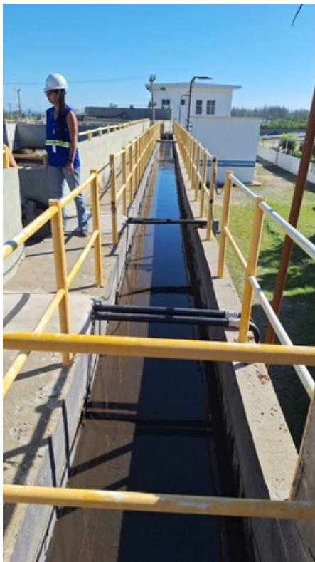
Foto 10 e 11 – Recirculação do lodo do decantador para o tanque de aeração; Dosagem do PAC na saída do tanque de aeração para otimizar a sedimentação no decantador.
