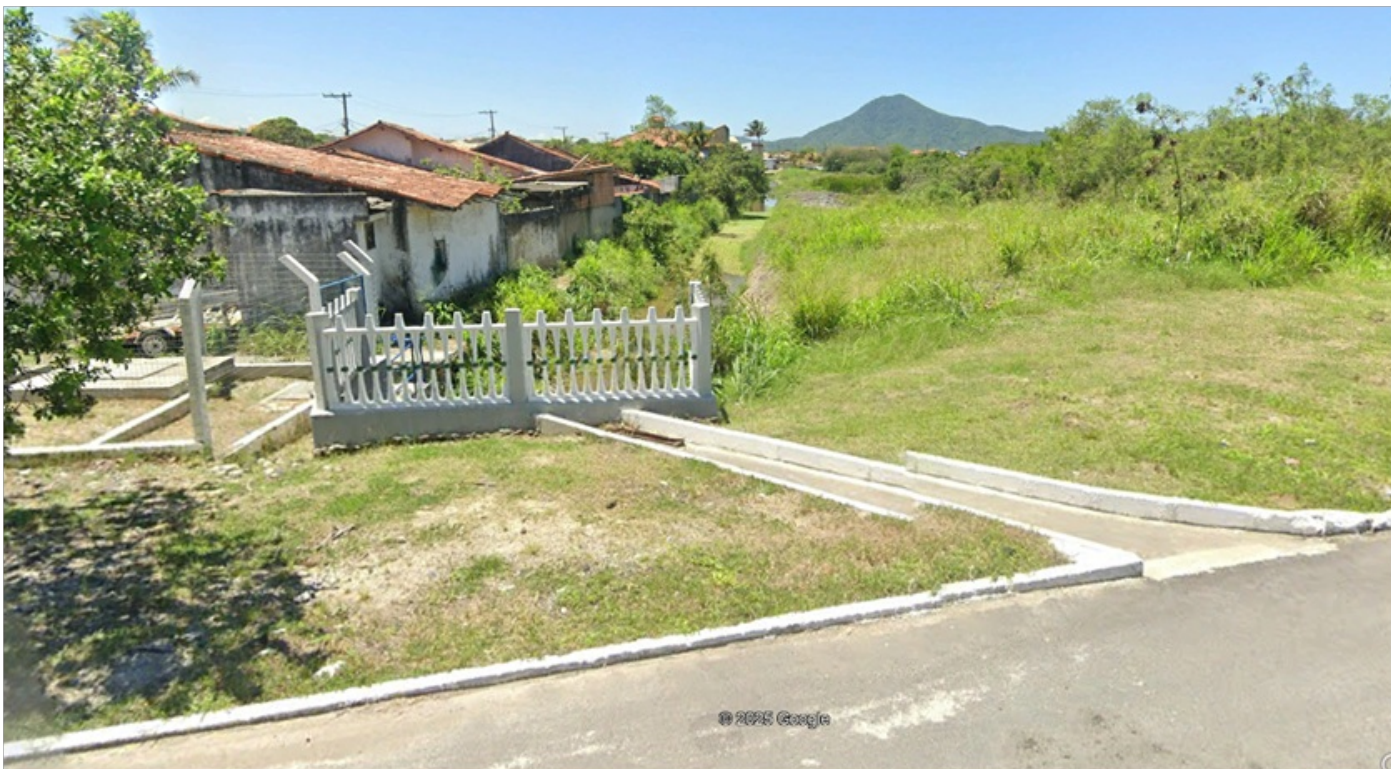
Foto 3 – Vista do canal que é captado pela EEE Ubás, que também recebe drenagem da Rodovia Amaral Peixoto.
