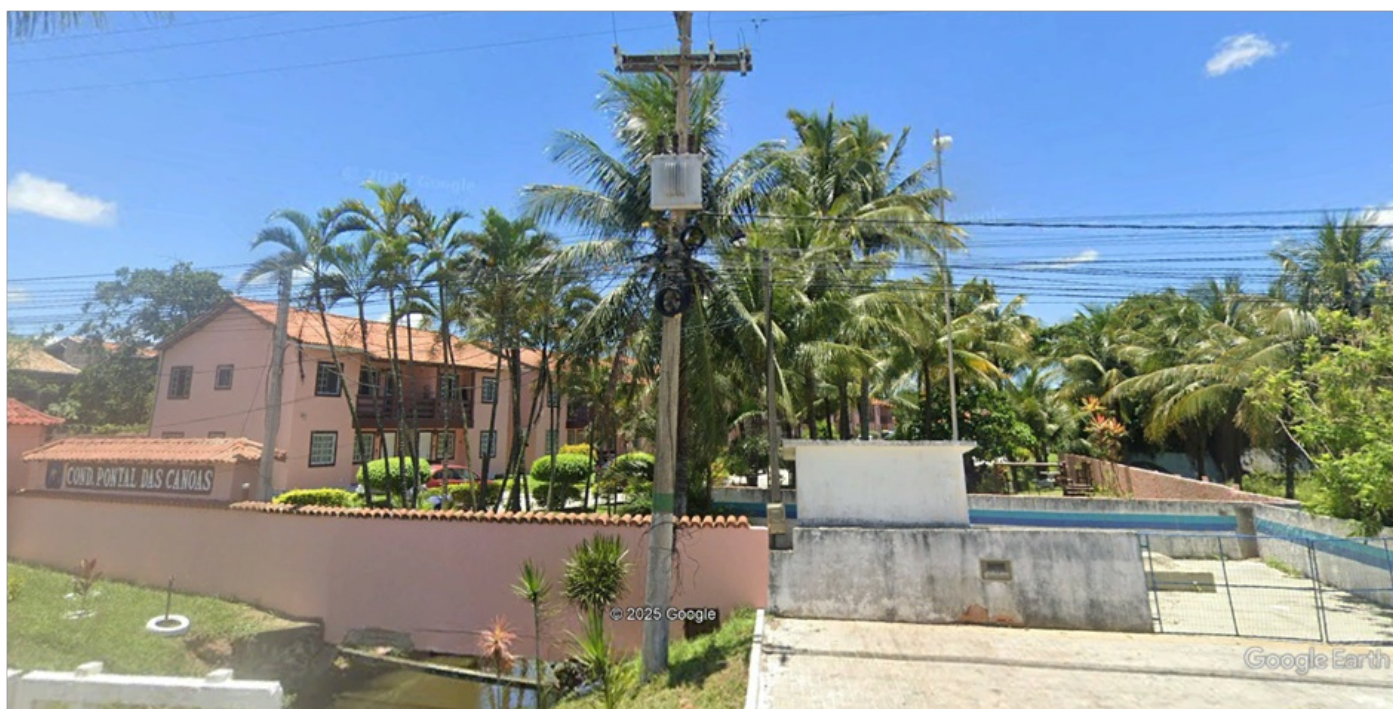
Foto 2 – Vista da entrada da EEE Santa Clara
