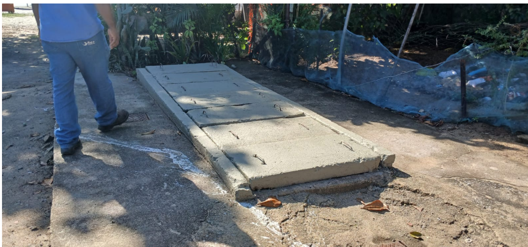
Foto 2 - Tampo de Concreto do abrigo subterrâneo
