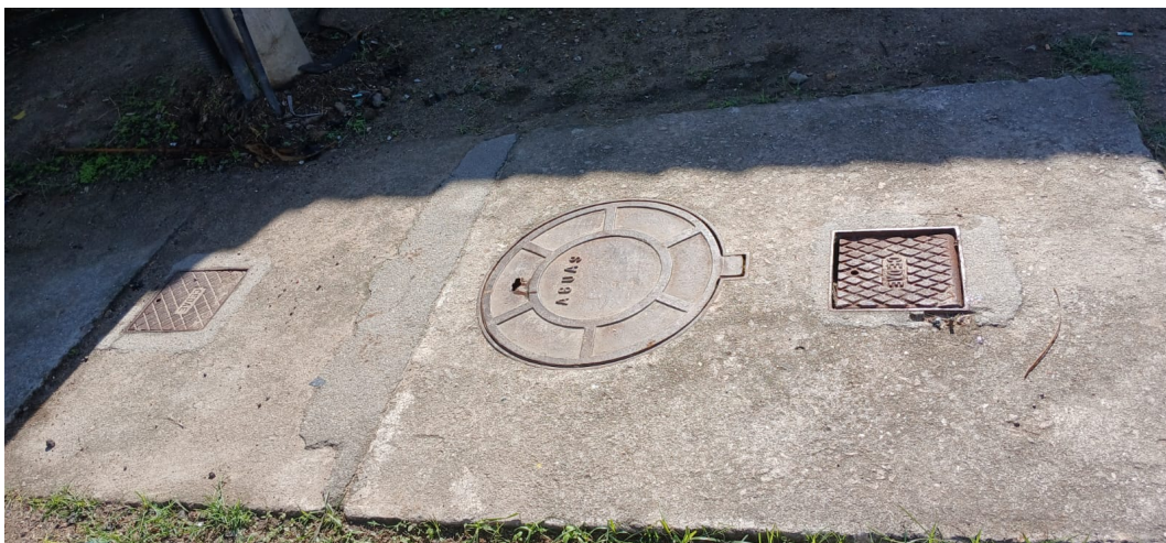
Foto 2 – Abrigo subterrâneo da EEAT com tampo de aço em bom estado
