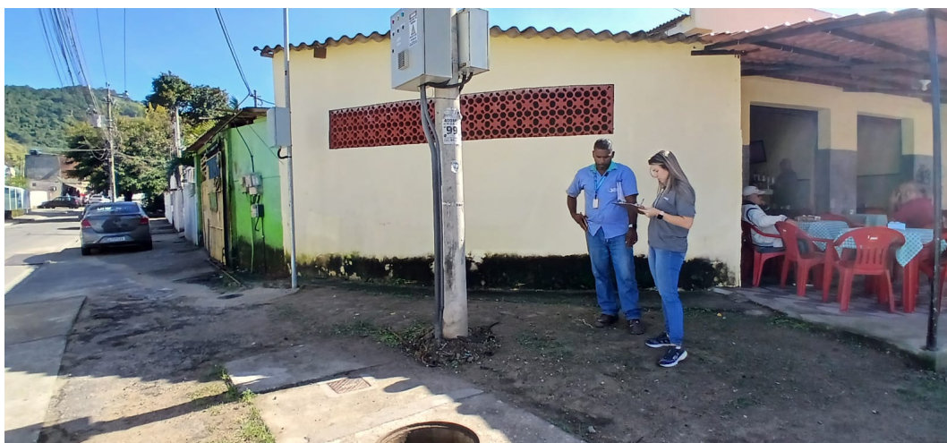
Foto 1 - Localização da EEAT sem identificação
