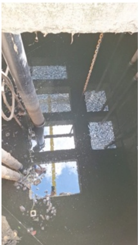
Fotos 5 e 6 – Poço da EEE, onde haviam peixes por captar a água do rio Salgado; PV de sucção do interceptor.
