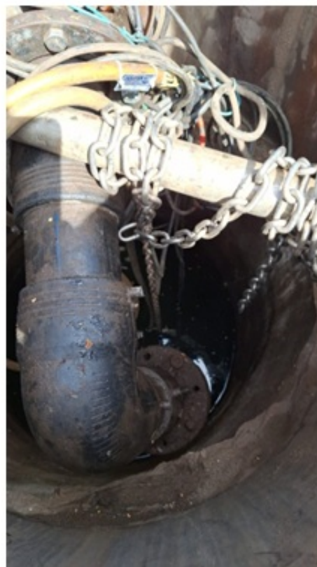
Fotos 5 e 6 – Poço da EEE, onde haviam peixes por captar a água do rio Salgado; PV de sucção do interceptor.
