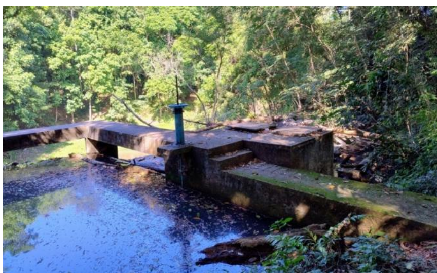
Foto 3 – Caixa de Tomada de água na Captação do Rio Caceribu
