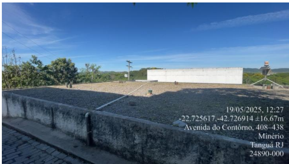
Foto 21 – Vista superior dos reservatórios
