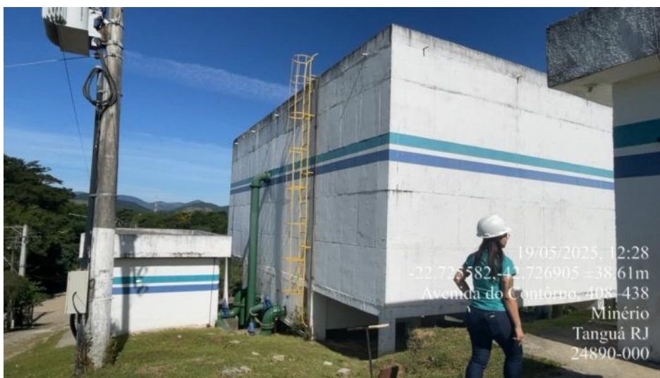
Foto 20 – Reservatório com escada com proteção
