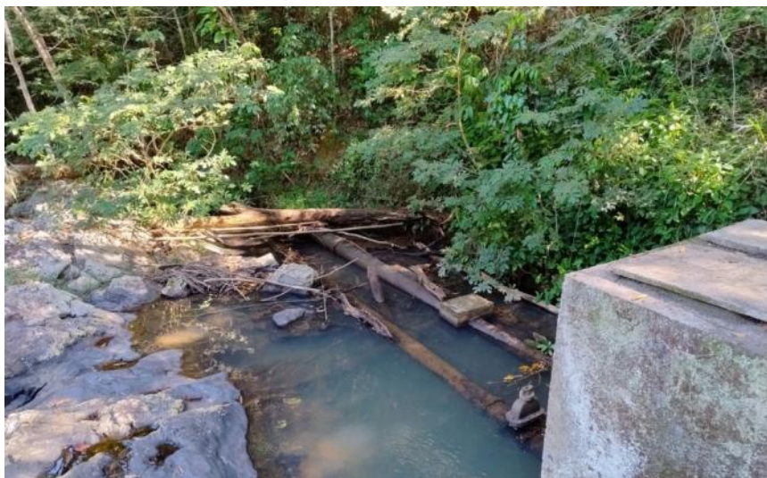
Foto 4 – Tubulações adutoras de água bruta
