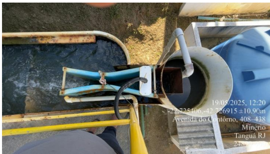
Foto 7 – Calha Parshall para medição de vazão de água bruta
