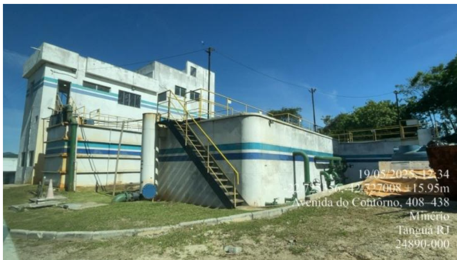
Foto 5 – Vista geral da ETA
