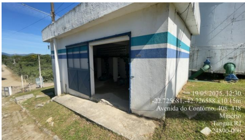
Foto 24 – Vista exterior da EEAT 2
