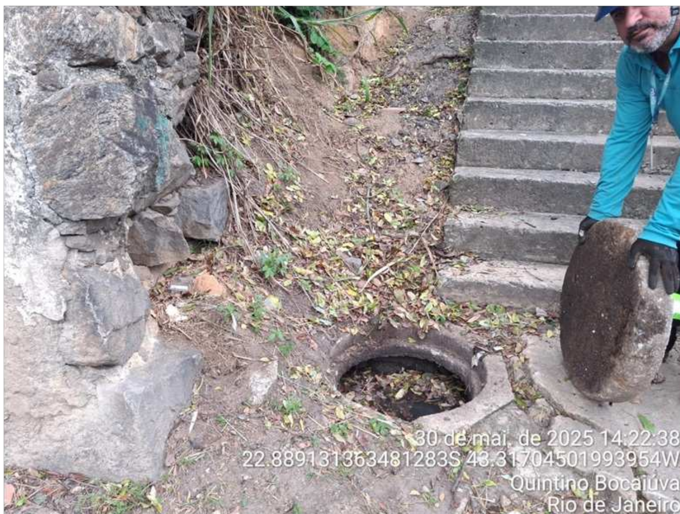
Foto 3 – PV de águas pluviais
