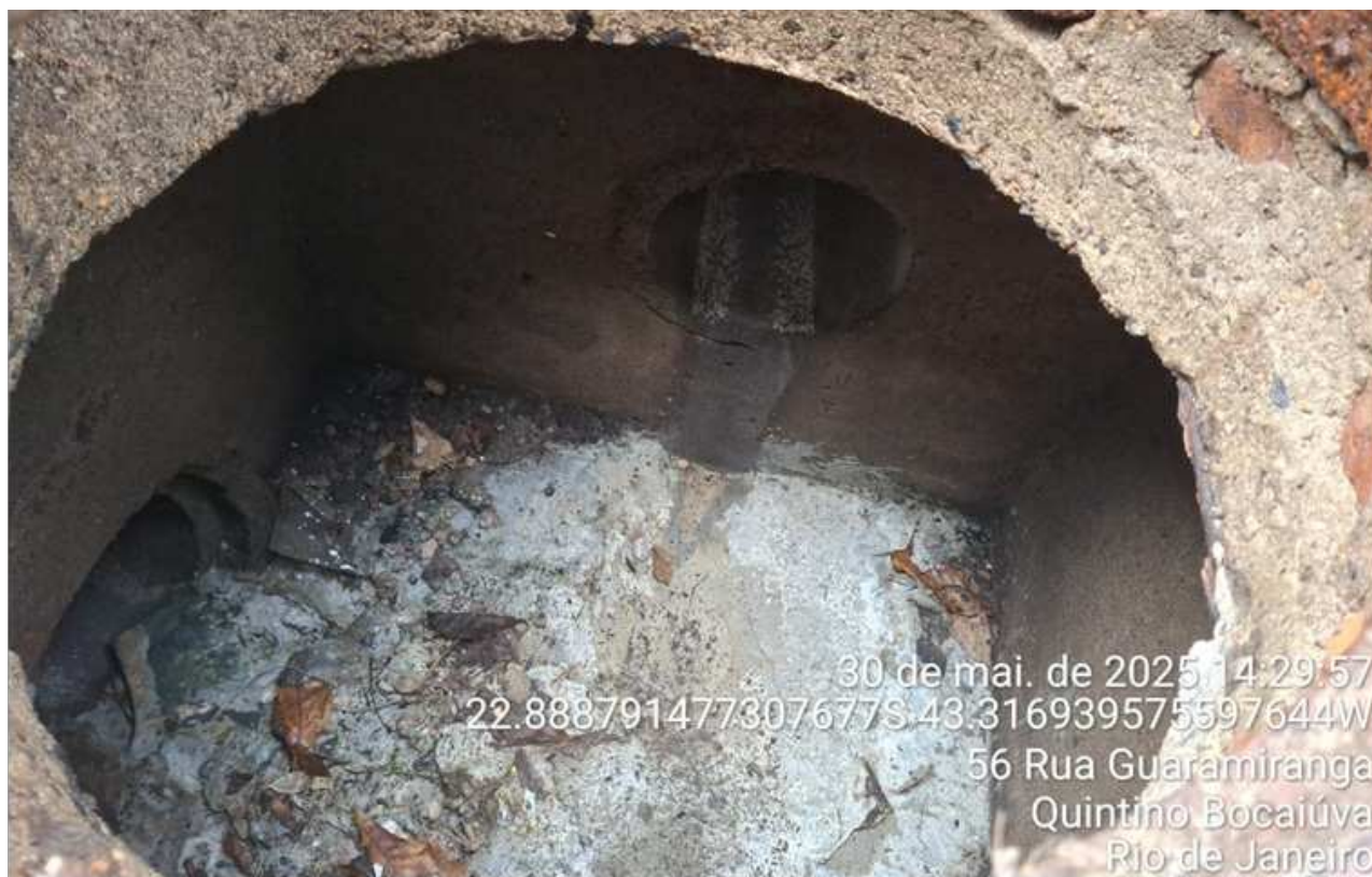
Foto 12 – PV de águas pluviais que recebe contribuição do coletor
