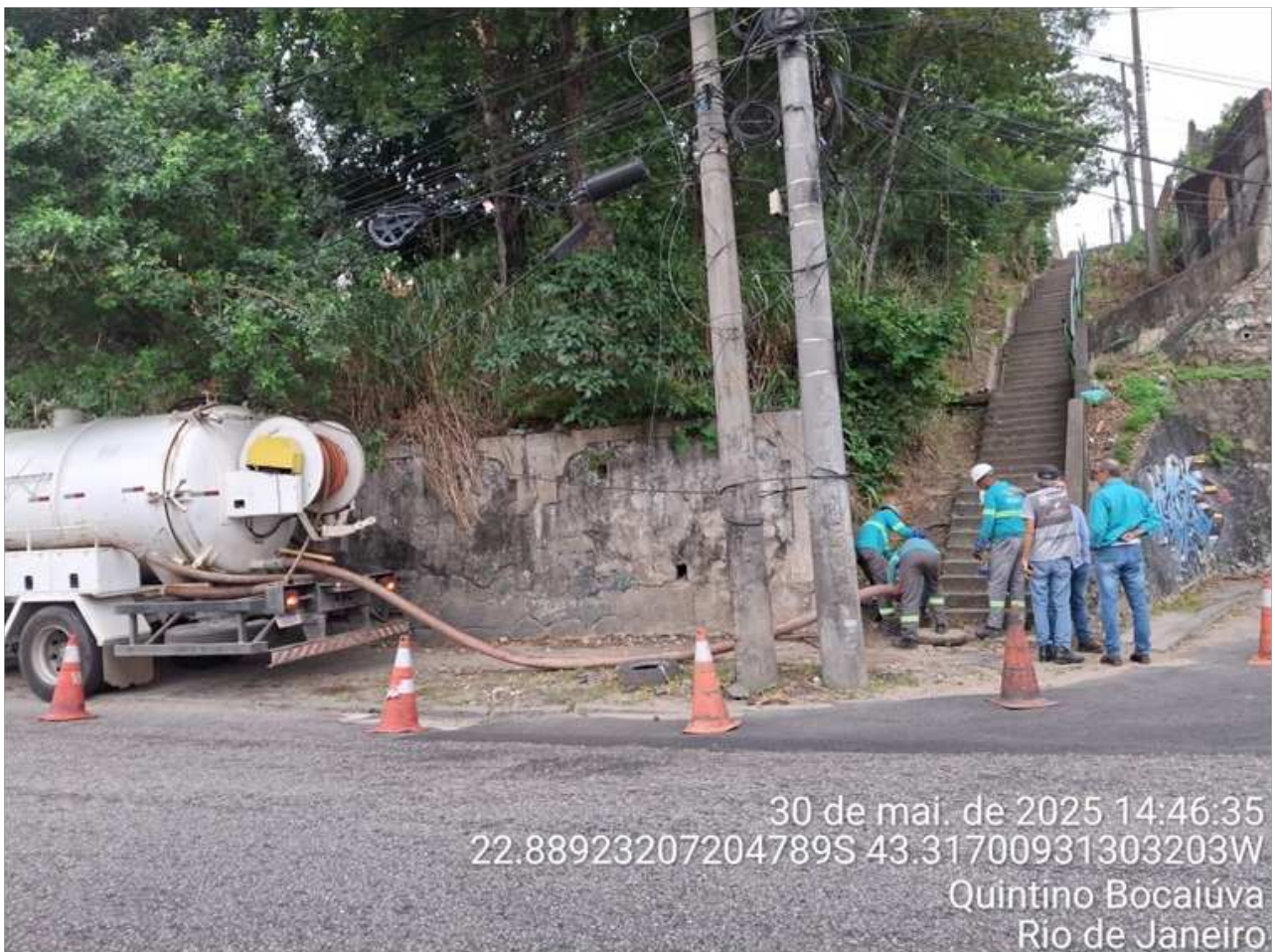
Foto 9 – Limpeza pela concessionária do PV de água pluvial que recebe contribuição de esgoto
