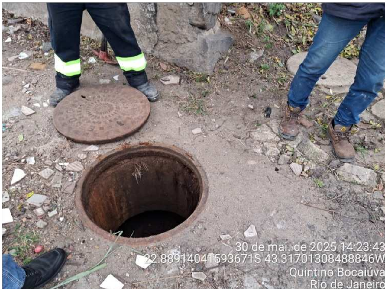
Foto 4 – PV de águas pluviais
