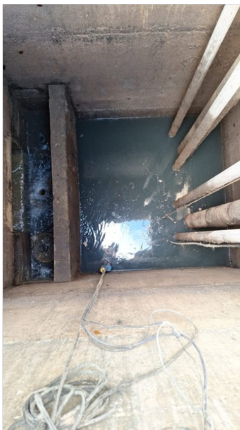
Foto 5 – Poço de sucção da EEE.
