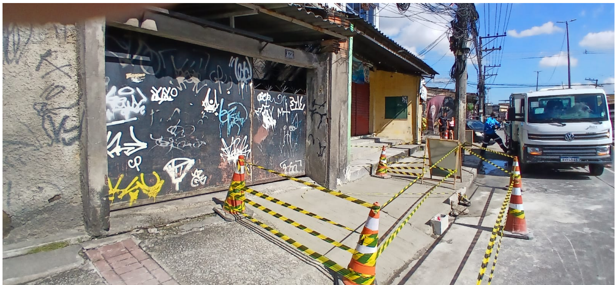
Foto 2 - Repavimentação em processo de finalização e devidamente cercada e sinalizada
