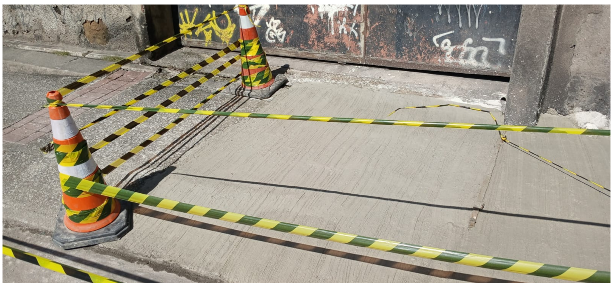
Foto 3 - Calçada reconstruída em frente ao imóvel 8751
