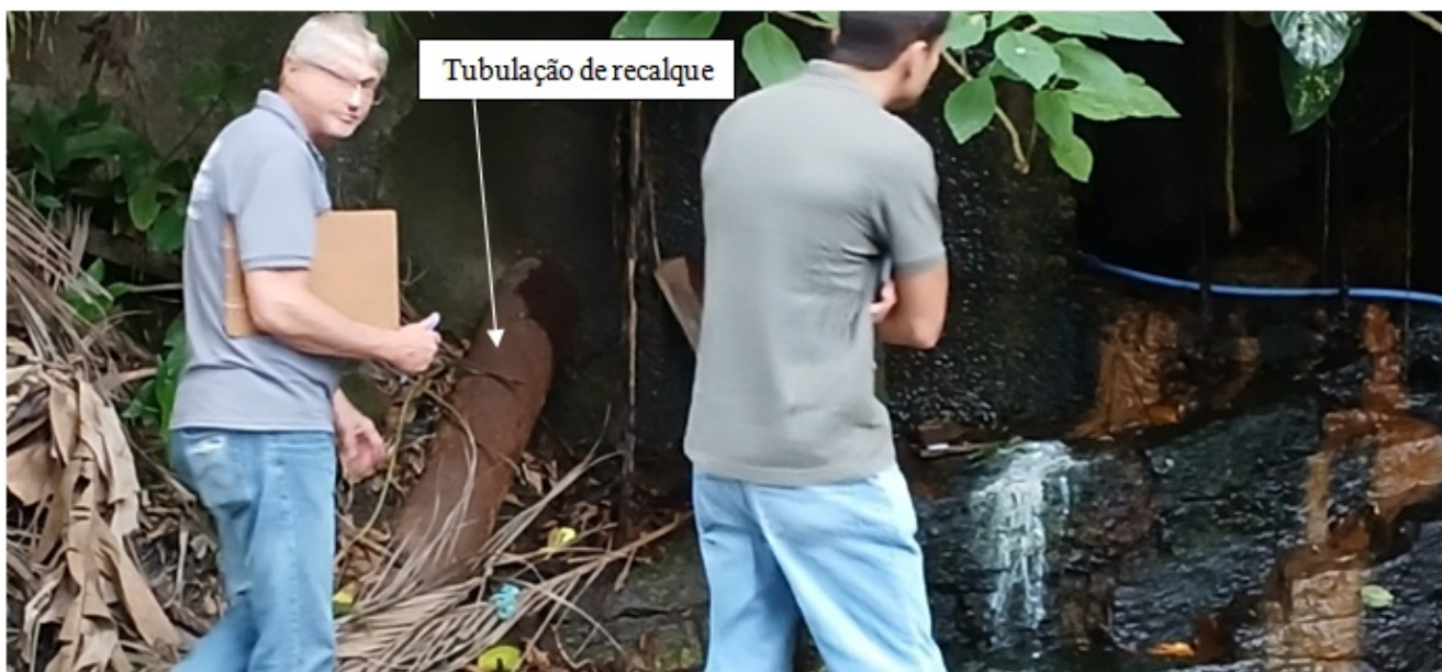
Foto 6 – Local do início da subida da tubulação de recalque
