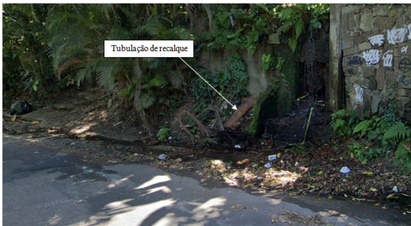
Foto 5 – Local do início da subida da tubulação de recalque (fonte Google Earth Pro)
