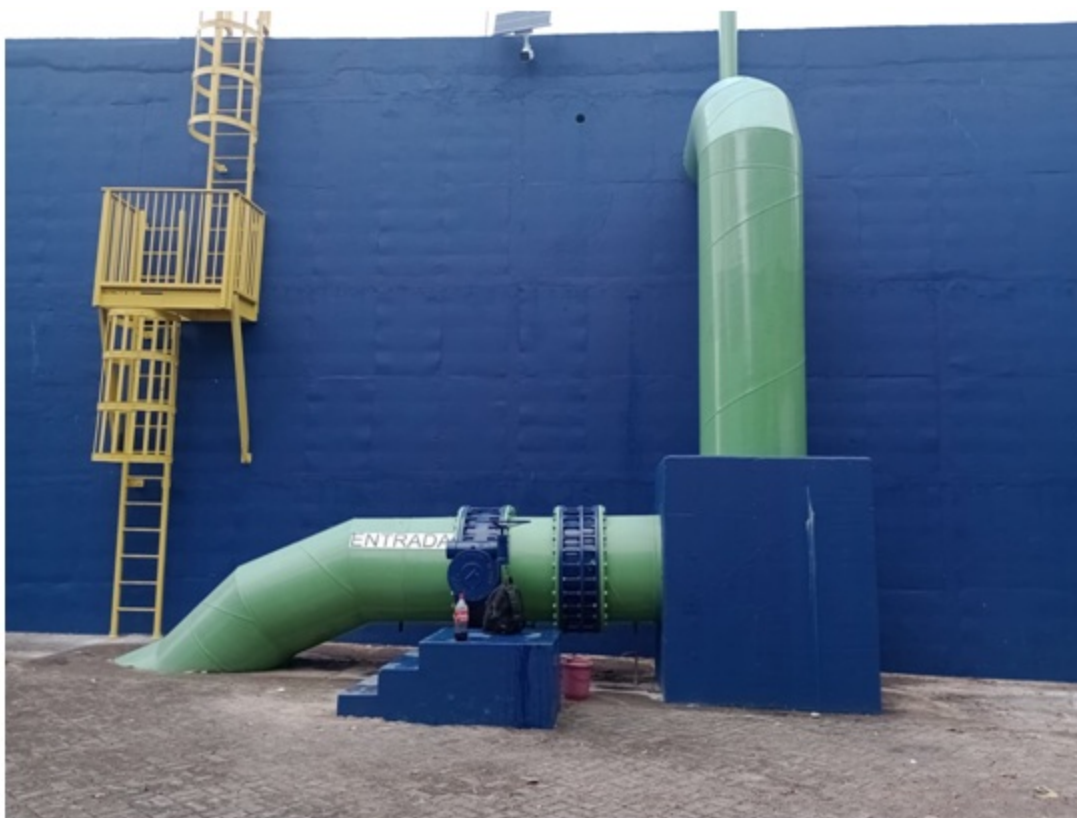
Foto 7 – Escada externa para a laje da 1ª célula
