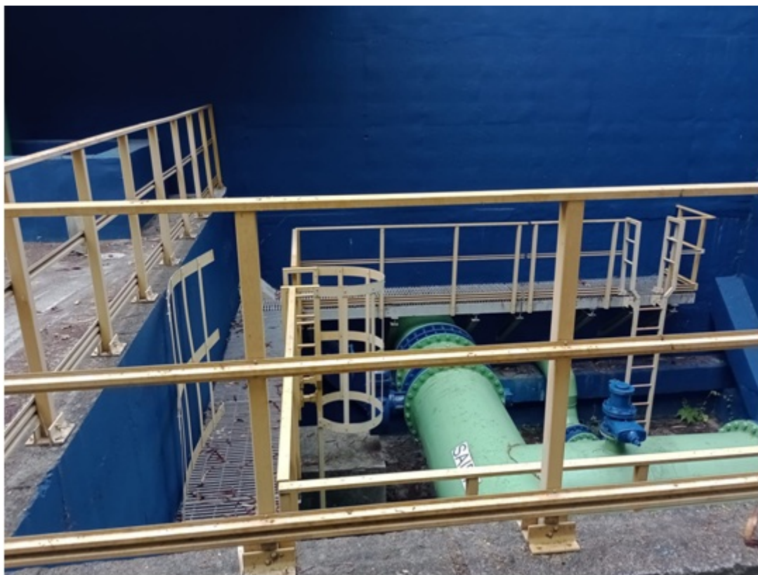
Foto 24 – Guarda corpo e escadas
