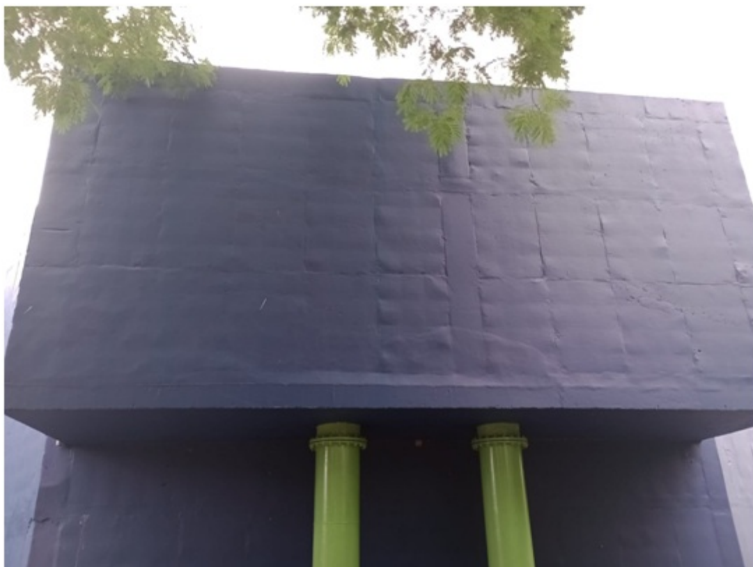
Foto 20 – Tubulações extravasoras da 1ª célula
