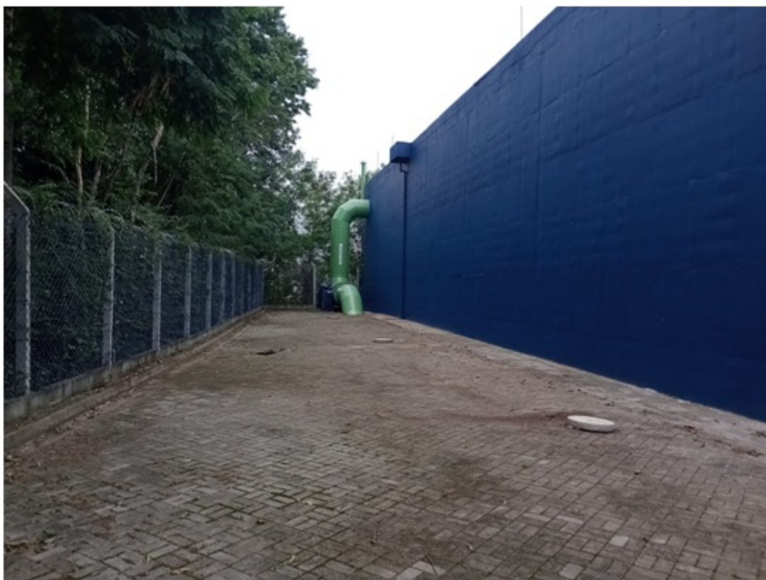
Foto 3 – Cerca de tela de arame e moirões de concreto
