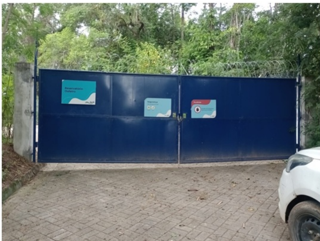
Foto 2 – Entrada do reservatório
