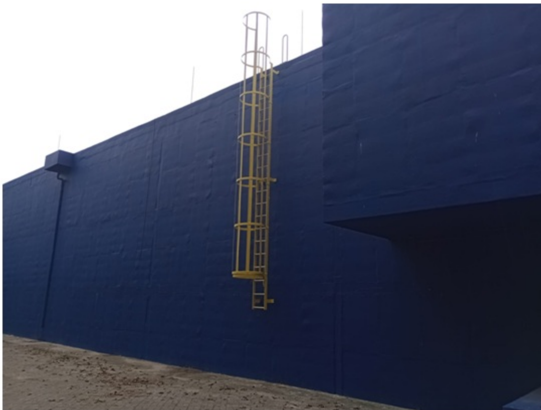
Foto 6 – Escada externa para a laje da 2ª célula
