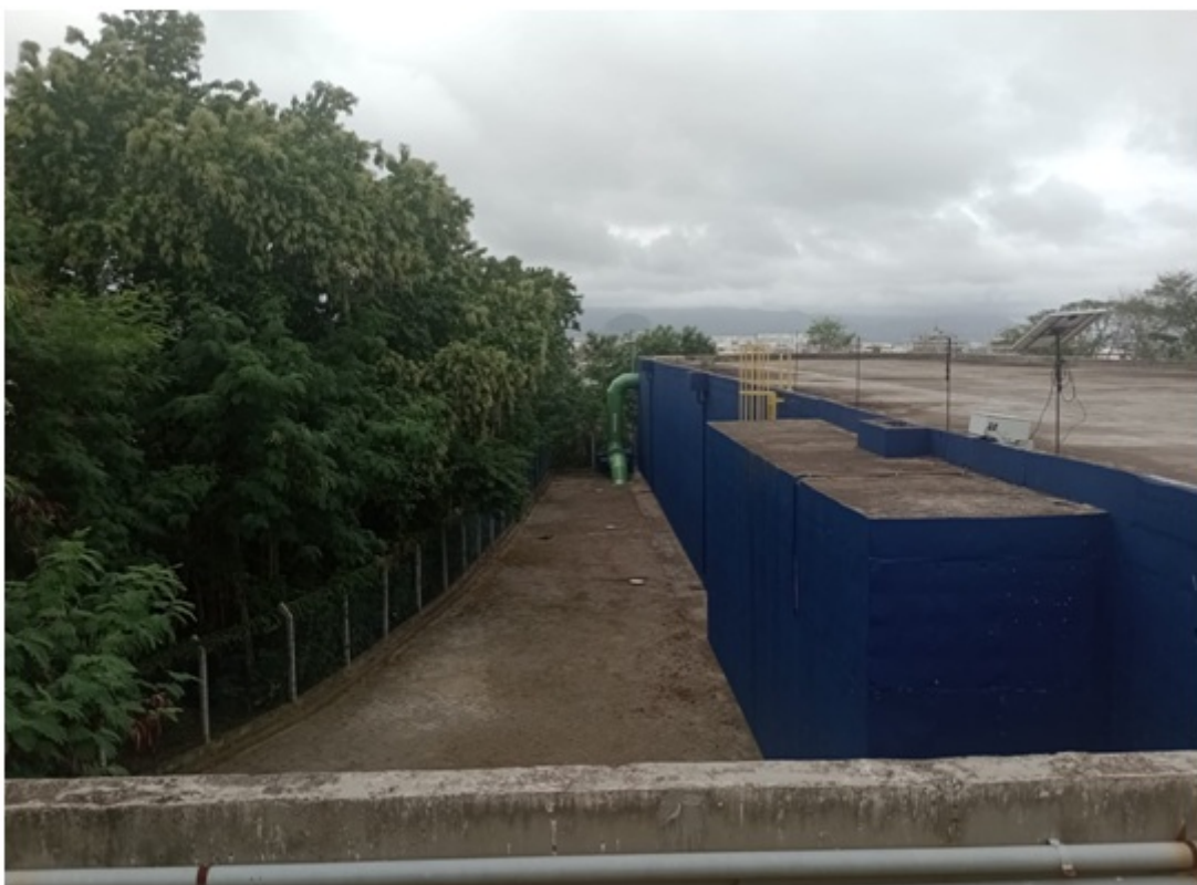
Foto 4 – Vista de uma das laterais da 2ª célula do reservatório
