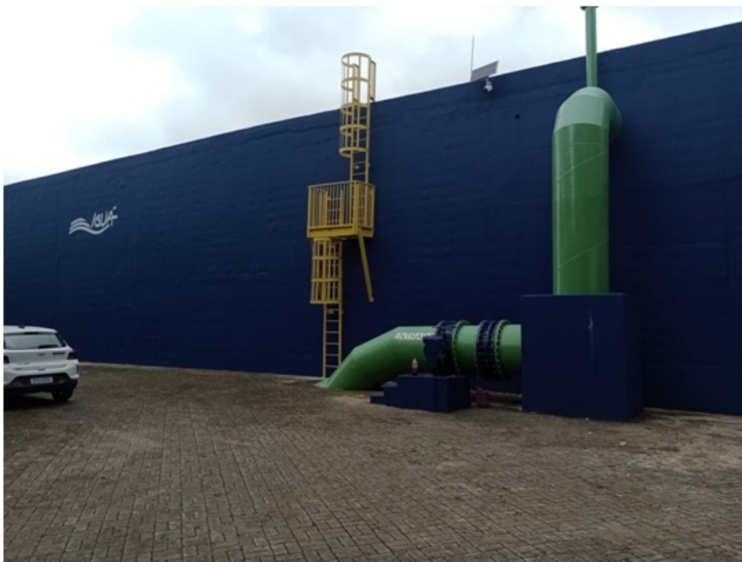
Foto 5 – Vista frontal da 1ª célula do reservatório
