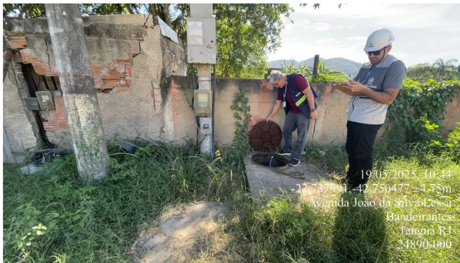
Foto 1 – Vista geral da EEAT
