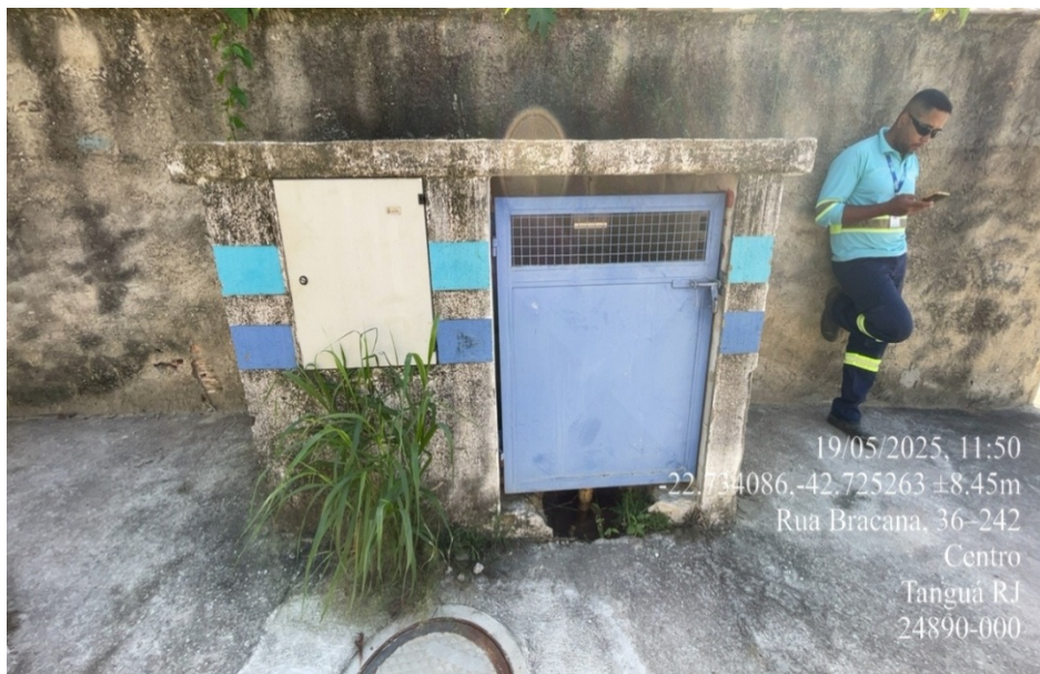
Foto 1 – Vista geral da EEAT
