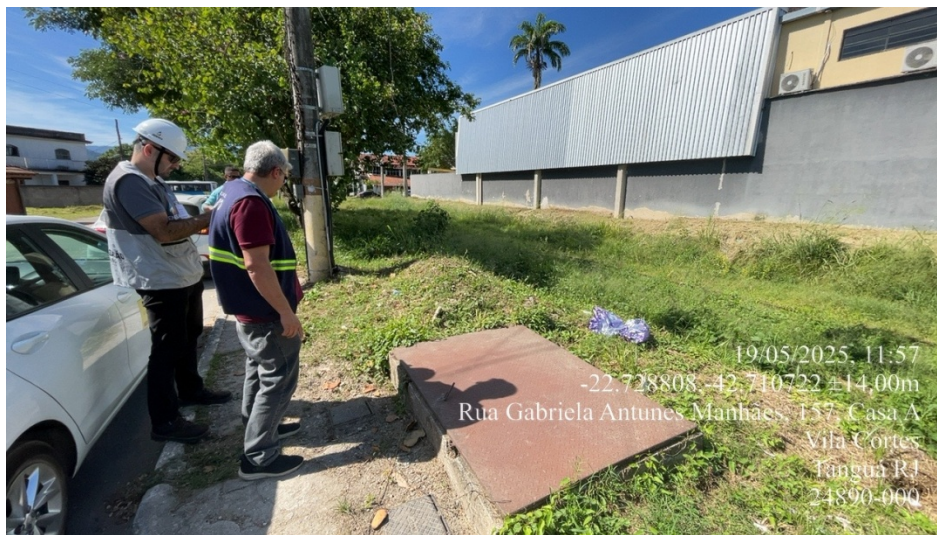
Foto 1 – Vista geral da EEAT
