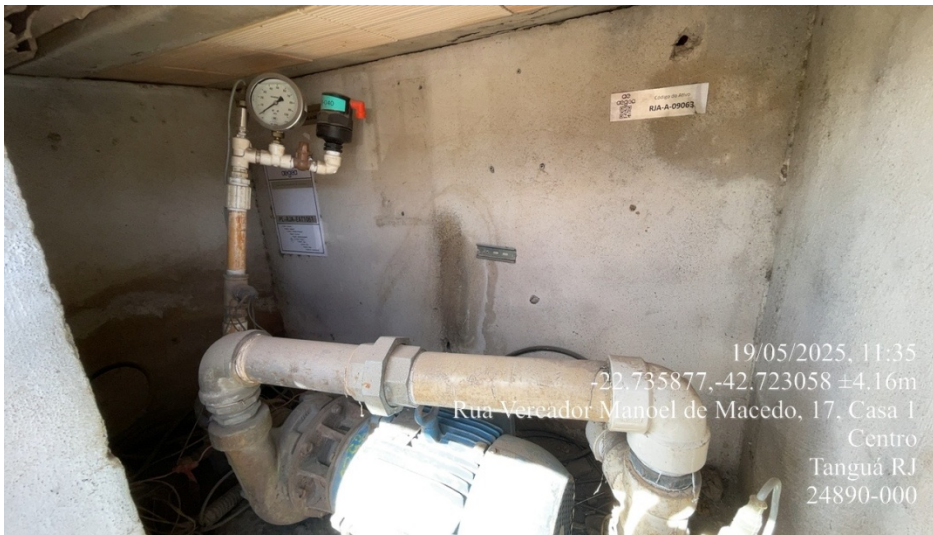
Foto 3 – Vista interna da EEAT
