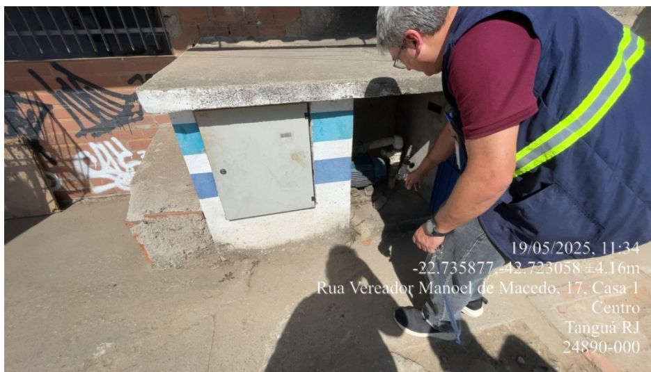
Foto 1 – Vista geral da EEAT
