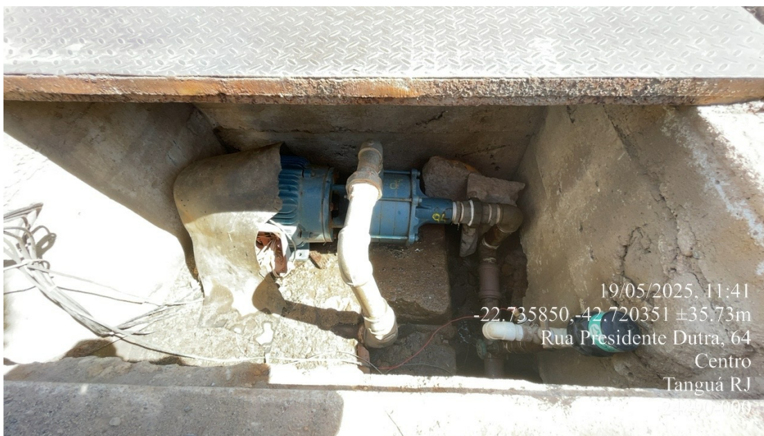
Foto 2 – Vista interna da EEAT em abrigo subterrâneo
