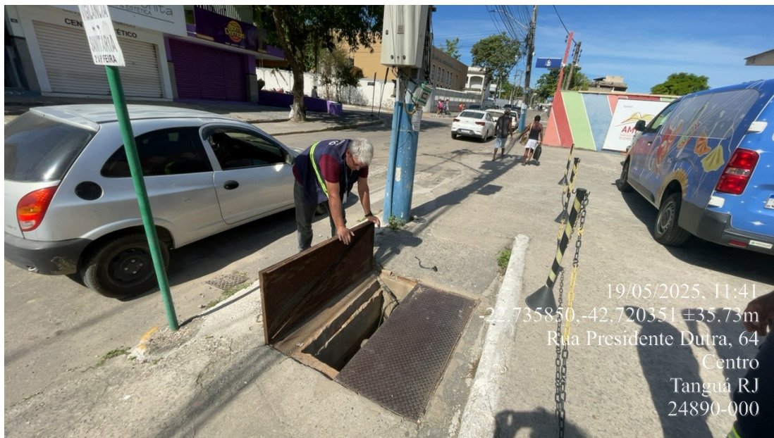
Foto 1 – Vista geral da EEAT
