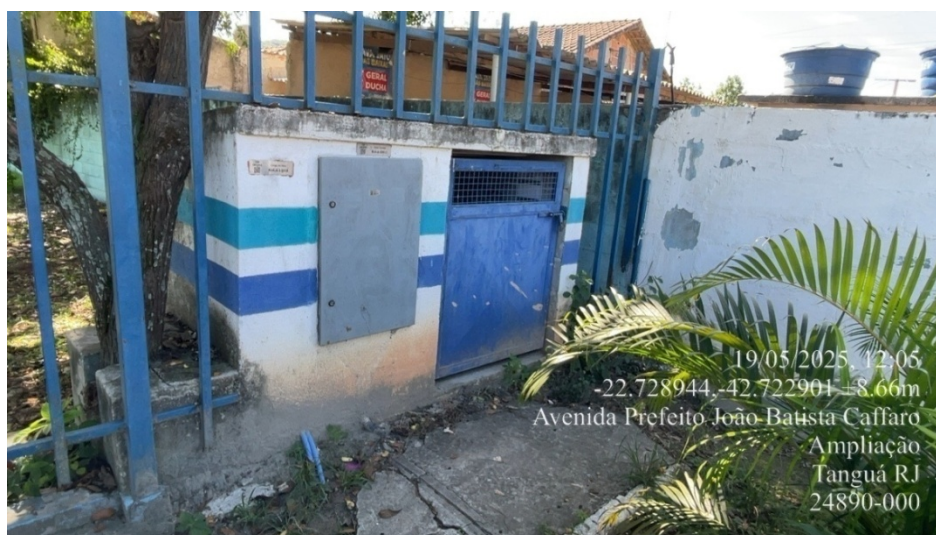
Foto 2 – Vista geral da EEAT
