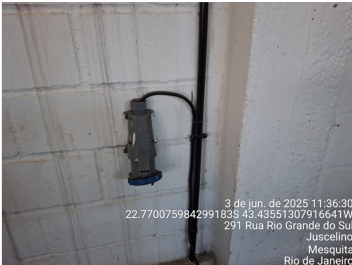
Foto 13 – Tomada específica gerador
