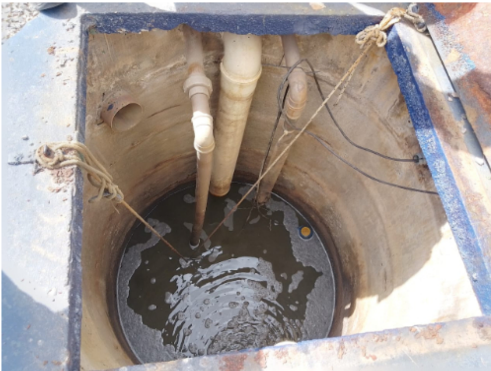
Figura 7. Poço de sucção da elevatória da ETE.
