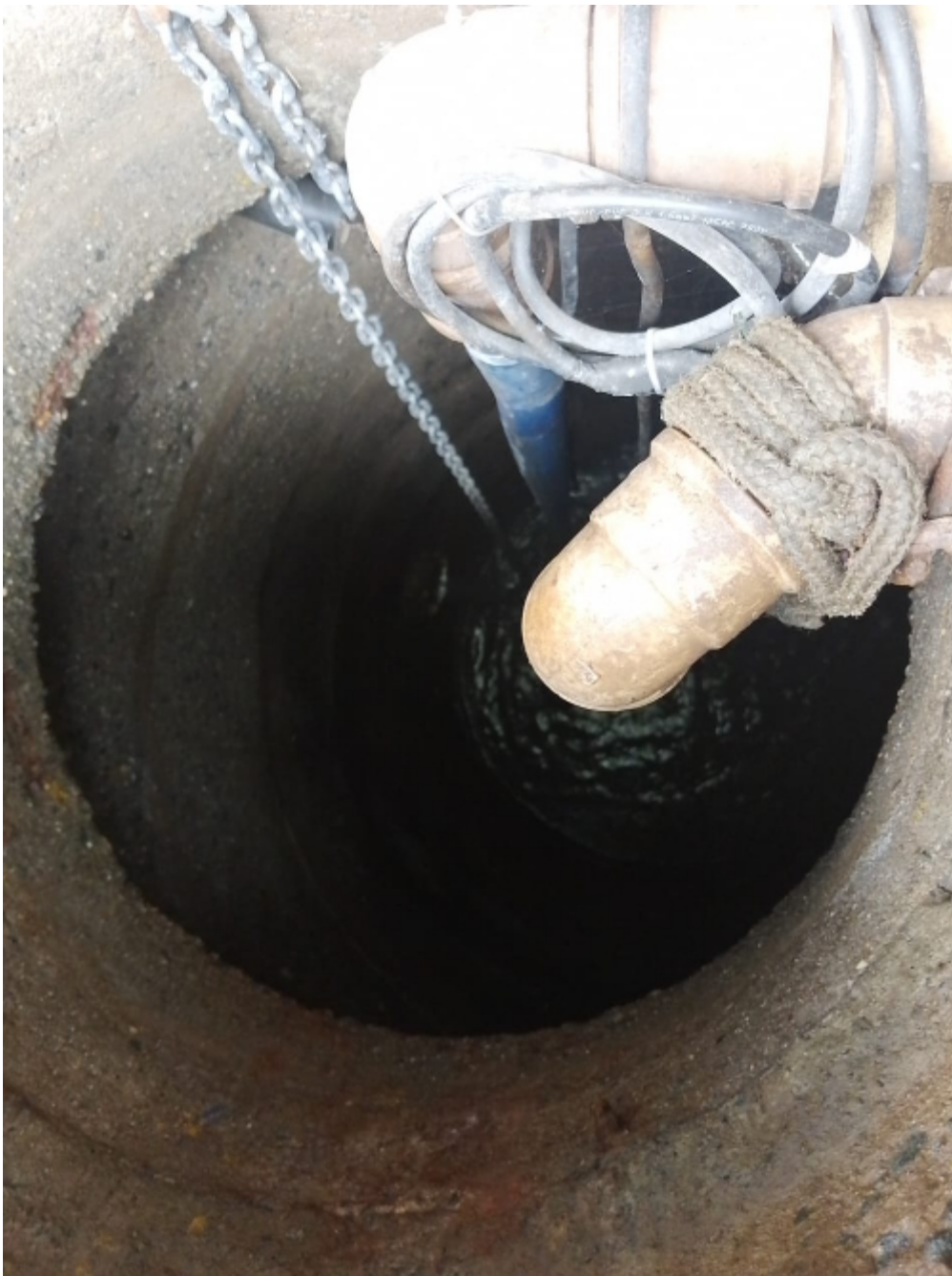
Figura 4. Poço de sucção da Elevatória de Esgoto Bruto.
