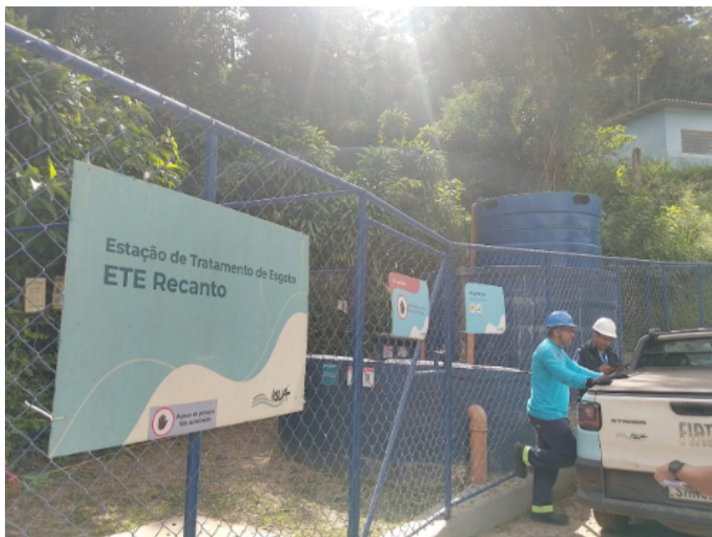
Figura 1. Identificação e cercamento da ETE Recanto.
