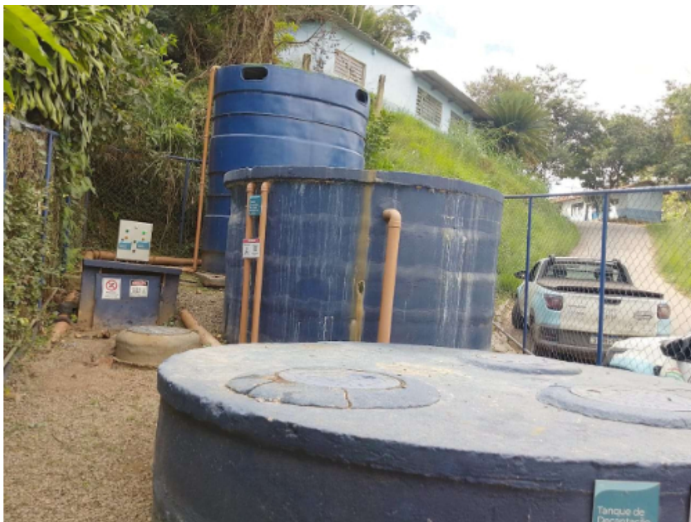
Figura 2. Estrutura da ETE Recanto.
