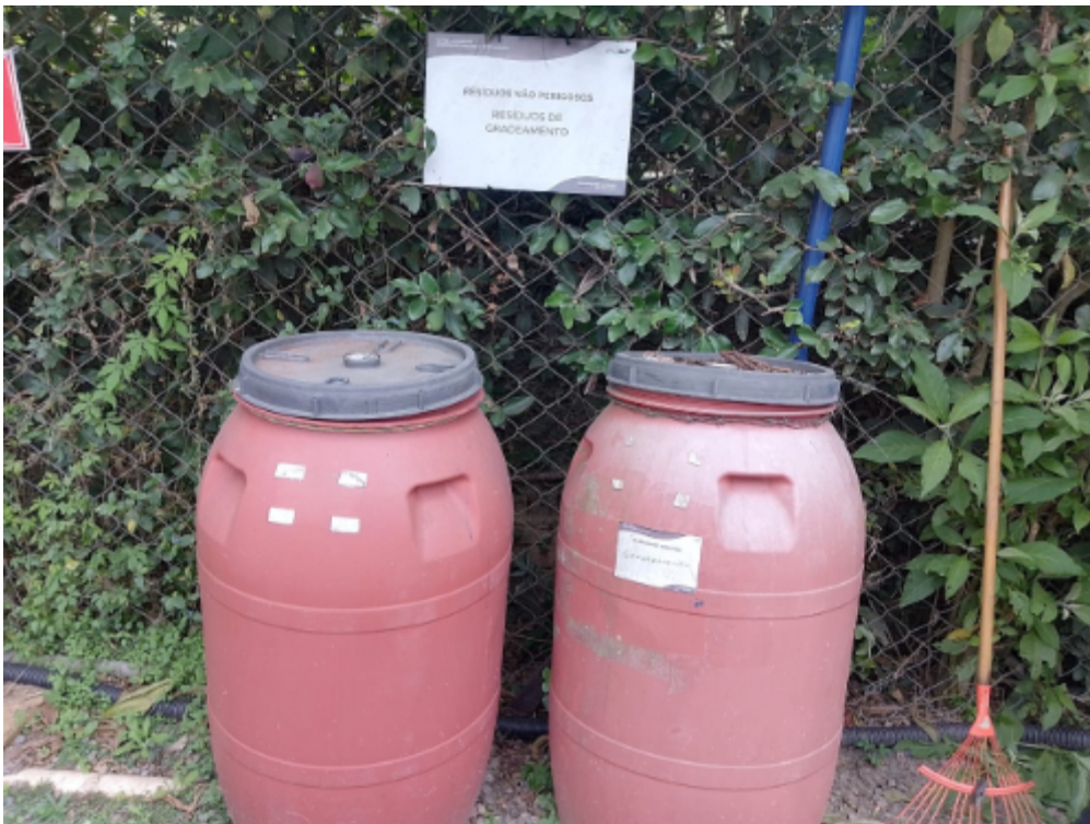
Figura 5. Tambor para armazenamento temporário dos resíduos do tratamento preliminar.
