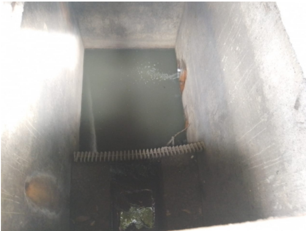
Figura 5. Gradeamento de entrada da EEEB.
